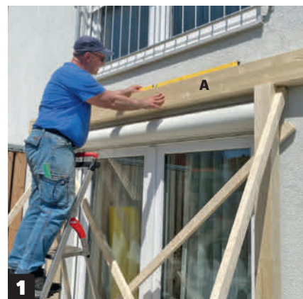
1 Remmen på væggen placeres oven på et midlertidigt stativ. Vær omhyggelig med, at remmen ligger helt lige.
