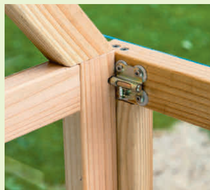
Päätyyn on porattu reikä lukkosalpaa varten. Se pitää seinän paikallaan.
