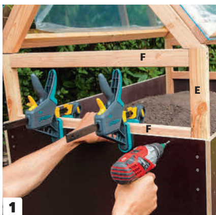
Asenna kasvihuone istutuslaatikkoon. Kiinnitä rimat (F) kumpaankin pätyyn ja ruuvaa rakennus kiinni. Yläosa kannattaa kiinnittää laatikkoon parilla puristimella ruuvaamisen ajaksi.
