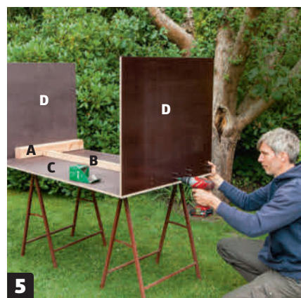
Kokoa laatikko. Ruuvaa poikkirima (B) nurkkatolppien (A) väliin ja asenna lyhyet sivut (D). Kiinnitä poikkirima 4x50 millin ruuveilla vanerin läpi.
