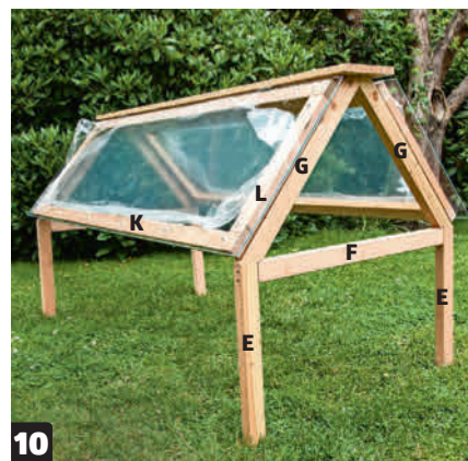
Kasvihuoneen katto alkaa muotoutua. Kattokehiot (K ja L) on asennettu, ja kasvihuoneesta puuttuu enää seinät. Ne asennetaan vasta, kun katos on kiinnitetty istutuslaatikkoon.
