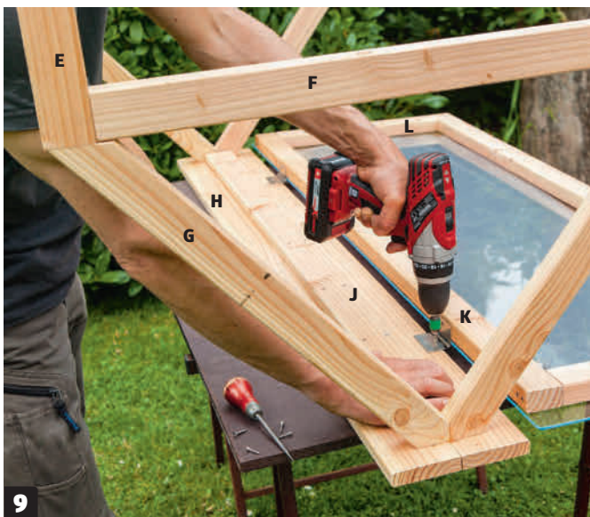
Asenna valmiit kehiot (K ja L) minikasvihuoneen runkoon. Kiinnitä isot kehiot harjaan (H) saranoidella, jotta voit avata katon.
