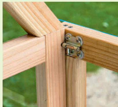
Det er boret et hull i gavlen for skåtebeslagene som holder siden på plass.
