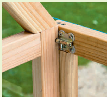
Der er boret et hul i gavlen til skudrigelbeslag, der holder siden på plads.
