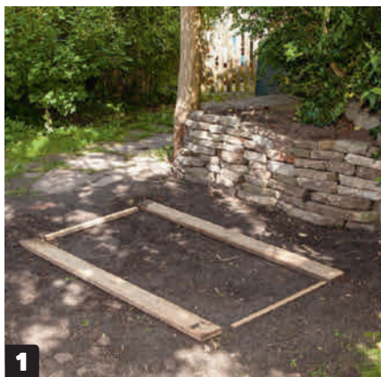
1 Lav en prøveoplægning, hvor du ønsker at placere minidrivhuset. Med et par brædder og lister på jorden får du nemt et indtryk af, hvor stort det skal være, og hvor det er optimalt at placere. Mål så op.
