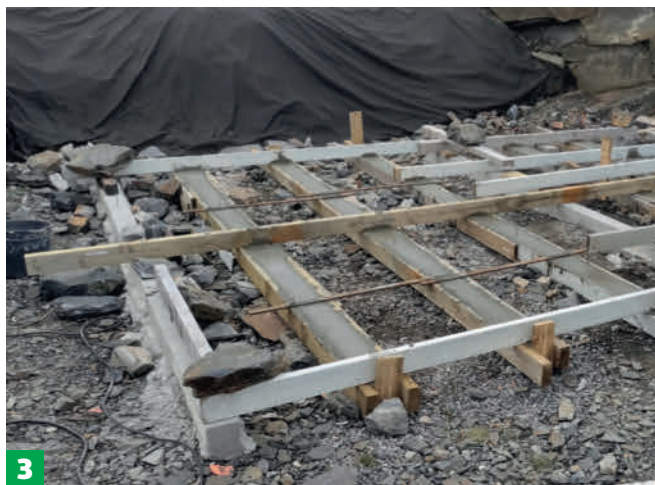
Kun muotit on tehty, voit täyttää ne betonilla. Tasoita betoni lankkujen pinnan tasolle. Muista tiivistää betoni kunnolla koputtamalla lankun kylkeen vasaralla.
