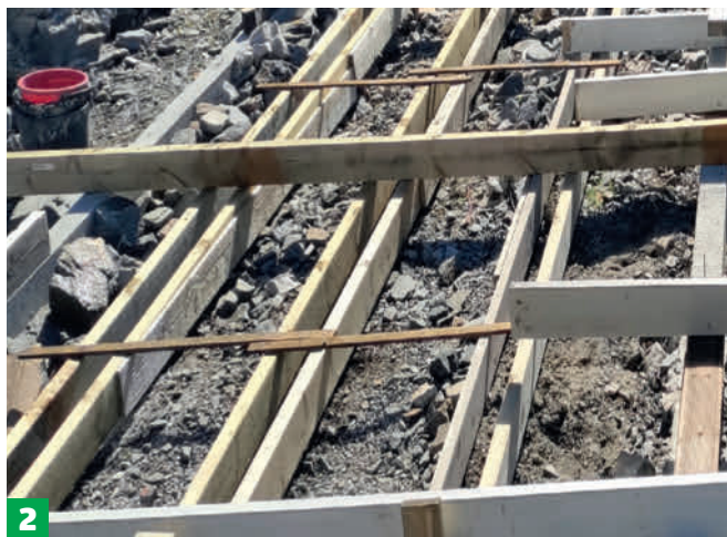
Asenna lankut poikittain reunimmaisten ja keskimmäisen betonituen päälle. Ruuvaa sen jälkeen muiden palkkien muottilankut kiinni poikittaisiin lankkuihin, jotta tuet tulevat samaan korkeuteen.
