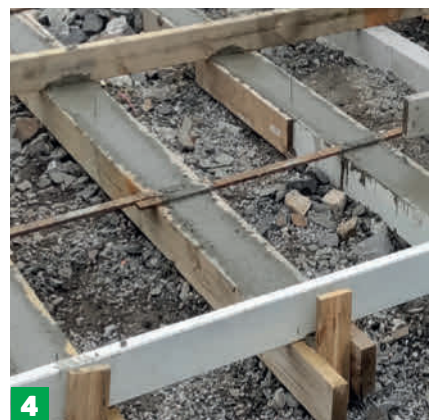
Jäykistä muotit rimoilla, jotta betoni ei taivuta lankkuja.
