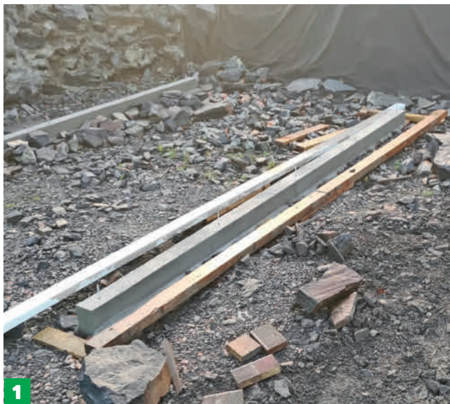
Upota betoniin kierretangot runkolankkujen asentamista varten. Tässä käytetään 8 millin galvanoituja kierretankoja.
