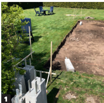
1 Kaiva pintamulta pois, jotta saat tehtyä kunnan pohjan terassin alle jäävälle säilytystilalle.
