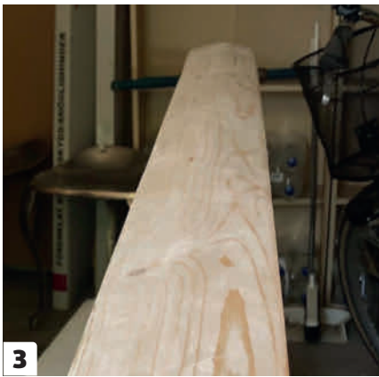
3 Kaiteiden päälle asennetaan lopuksi käsijohde, joka viimeistelee kaiken siististi.
