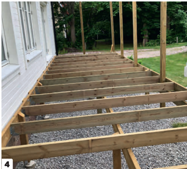
2 Kiinnitä sekä palkit että tolpat lyhyillä kansiruuveilla. Upota ruuvien kannat palkkeihin, jotta voit asentaa myöhemmin reunalaudat.
