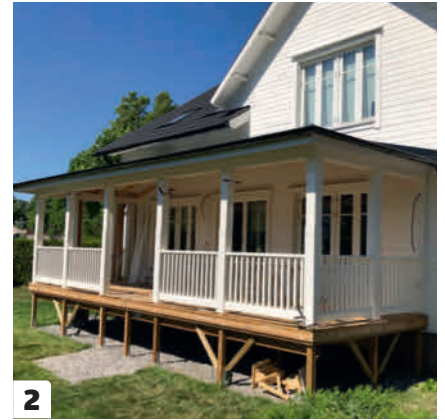
2 Asenna kaide-elementit valmiisiin väleihin. Kaiteet asennetaan tässä 5 senttiä terassin yläpuolelle.
