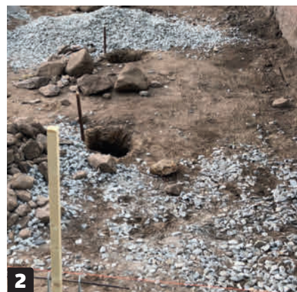
2 Kaiva kuopat tolppakiville. Nämä tolppakivet asennetaan tiivistetyn murskeen päälle. Kuopat ovat yhtä syviä kuin kivet ovat pitkiä.
