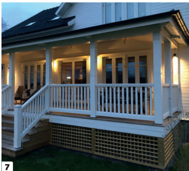
7 Kuistin alla oleva säilytystila peitetään elementeillä, joiden läpi ilma pääsee kiertämään. Ristikot tehdään rimoista ja öljytään lopuksi. Nämä rimat on halkaistu 22x145 millin laudoista.
