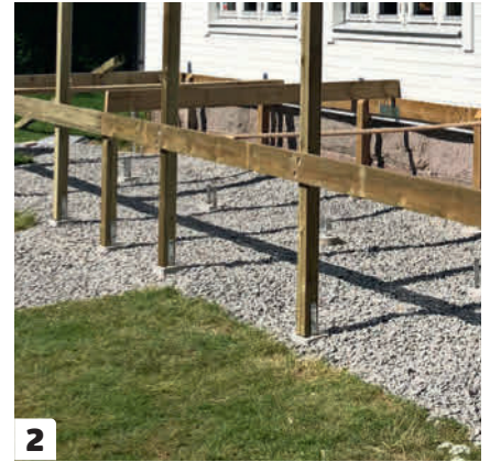
2 Kiinnitä sekä palkit että tolpat lyhyillä kansiruuveilla. Upota ruuvien kannat palkkeihin, jotta voit asentaa myöhemmin reunalaudat.
