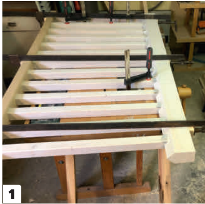
1 Kaiteet tehdään ja maalataan verstaalla valmiiksi tarkkojen mittojen mukaan ennen asentamista.
