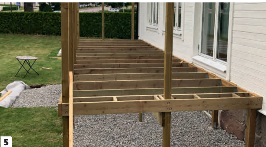
5 Molempiin päihin asennetaan ylimääräinen runkolankku, jotta terassin reunaan voi asentaa peitelaudan.
