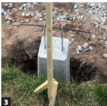
3 Pystytä "puujalat" tolpparivien kohdalle ja viritä niiden väliin linjalangat. Se on helppo tapa varmistaa, että tolppakivet tulevat samaan linjaan ja oikeaan korkoon.
