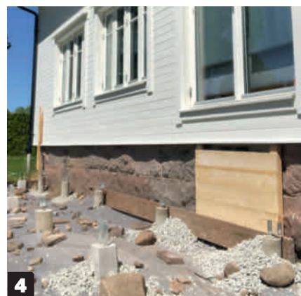
4 Kun tolppakivet on asennettu, niiden väliin levitetään kuitukangas, jotta sora ei vajoa maan sisään.
