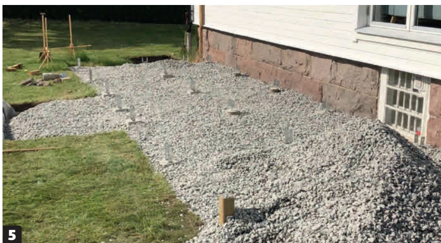
5 Levitä kuitukankaan päälle 5–10 sentin kerros soraa. Se pitää kankaan paikallaan ja muodostaa tasaisen pohjan kuistin alla olevalle säilytystilalle.
