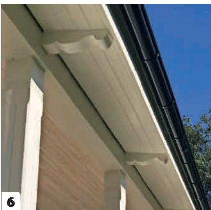
6 Sekä tolpat että palkkien päät ovat koristeellisia. Urat tehdään sapluunan avulla pistosahalla ja pitkällä terällä.
