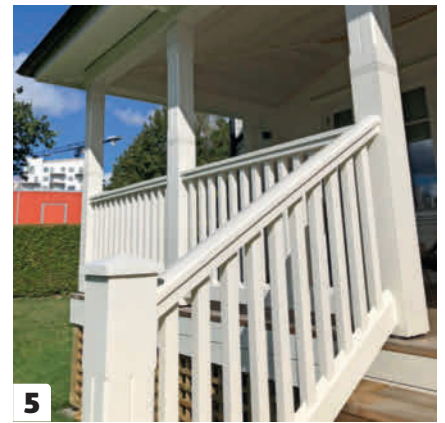
5 Portaiden kaiteet ovat vinot, joten niiden mittaamisessa ja osien sahaamisessa pitää olla tarkkana.
