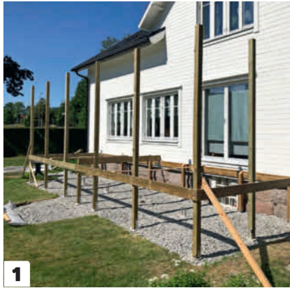
1 Asenna tolpat tolppakenkiin ja ruuvaa samalla kiinni vaakapalkit, jotka rajaavat terassin. Ne vakauttavat pitkät tolpat.
