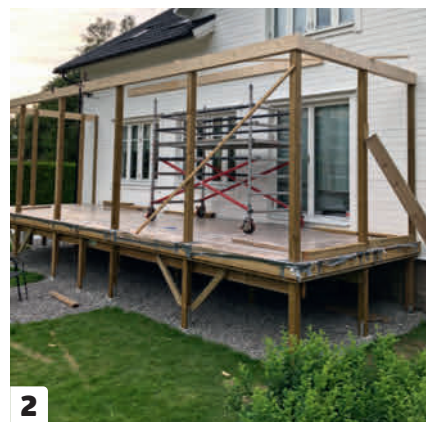
2 Såga ut för hammarbandet överst på varje stolpe. Uttaget är 45 x 195 mm, så det är bara den ena halvan av den dubbla regeln som vilar på stolparna.
