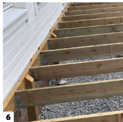
6 Det är en god idé att tänka på konstruktivt träskydd när du bygger. Detta görs till exempel genom att kapa ändarna på stolparna diagonalt och skapa ventilation bakom bärslinan på fasaden med distanser.
