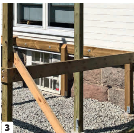
3 Bärslinan som sitter på husets fasad fästs med franska skruv. Om fasaden inte är skruvfast är det nödvändigt att stödja den med stolpar, som här.
