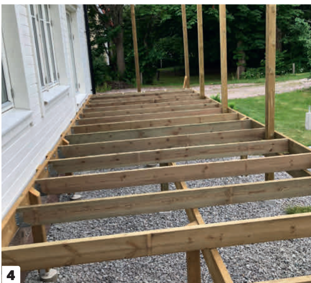
1 Sätt stolparna i plintarnas stolpskor och skruva samtidigt fast den vågräta bärslinan som utgör trädäckets ram. Detta stabiliserar de höga stolparna.
