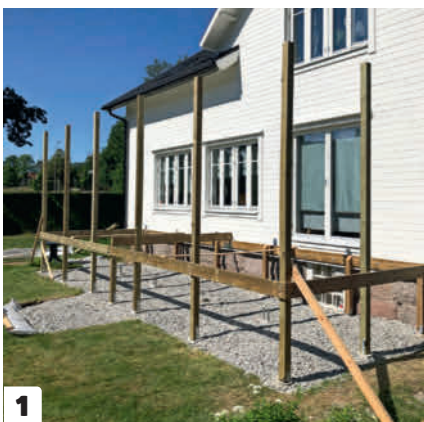
1 Sätt stolparna i plintarnas stolpskor och skruva samtidigt fast den vågräta bärslinan som utgör trädäckets ram. Detta stabiliserar de höga stolparna.
