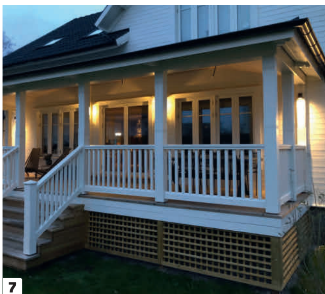
7 Förvaringsutrymmet under verandan döljs och ventileras genom "flätade" moduler. De består av ribbor och oljas till sist med naturolja. De här ribborna har sågats till av 22 x 145 mm brädor.
