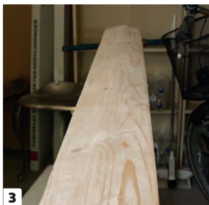
3 Ovanpå räckesmodulerna sätts till sist en anpassad överliggare, som avslutar det hela på ett snyggt sätt.
