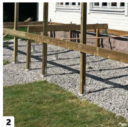
2 Både bärlina och stolpar fästs med korta franska skruv. I bärslinan försänks skruvarna så att de inte kommer i vägen för den kantbräda som ska monteras senare.
