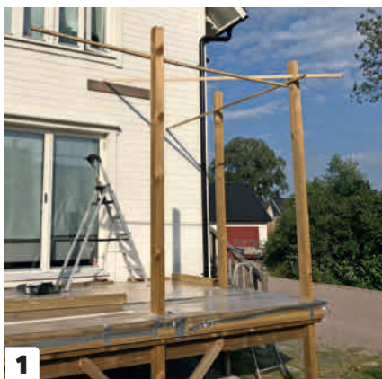
1 Rätta upp de stående stolparna med ribbor innan du sätter hammarbandet. Skruva fast ribborna på insidan av stolparna, så att de inte sitter i vägen för hammarbandet.
