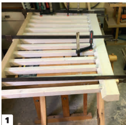
1 Räcket spikas ihop och målas i verkstan innan det sätts ihop. Om du inte vågar dig på det, kan du köpa och anpassa något prefabricerat.
