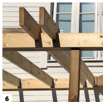
6 Såga ett hack i alla sparrar och fäst sparrarna i hammarbandet med vinkelbeslag. Om hacken är för djupa kommer de att försvagas. Såga därför max 1/3 in i sparrarna när du gör hacket.
