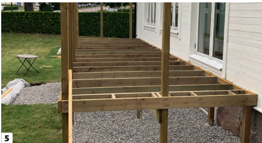
5 Dubbla regler sätts i bjälklagets båda ändar, eftersom en bräda ska sättas hela vägen runt kanten som avslutning på trädäcket.
