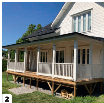
2 Räcket sätts upp i färdiga moduler. Se till att höja det ca 5 cm över trädäckets så att det inte står i regnvatten.
