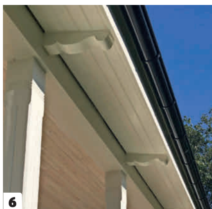
6 Precis som stolparna får sparrarna lite snickarglädje. Sågningarna görs med hjälp av en mall med det önskade mönstret och en sticksåg med extra långt blad.
