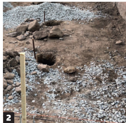
2 Grav hull til fundamentene. Her plasseres fundamentstein på et stampet underlag av drenerende grus, så hullene skal ikke være dypere enn selve steinene.
