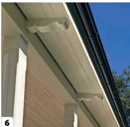
6 Kunstige sperreender lages under takutstikket. Utskjæringene på dem lages ved hjelp av en mal med ønsket mønster, og en stikksag med et ekstra langt blad. Har du tilgang til en båndsag, er det enda bedre.
