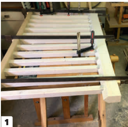
1 Rekkverket lages og males i verkstedet før det monteres. Hvis du ikke føler for å gjøre en like stor jobb, kan du eventuelt kjøpe og tilpasse noe som er prefabrikkert.
