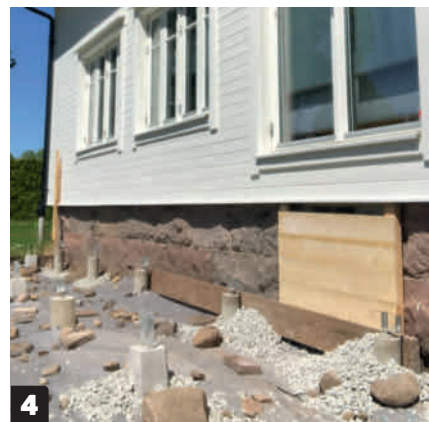
4 Når alle fundamentsteinene er plassert, legges det ut en fiberduk for at unngå ugress nedenfra, og for å unngå at pukken blander seg med underlaget.
