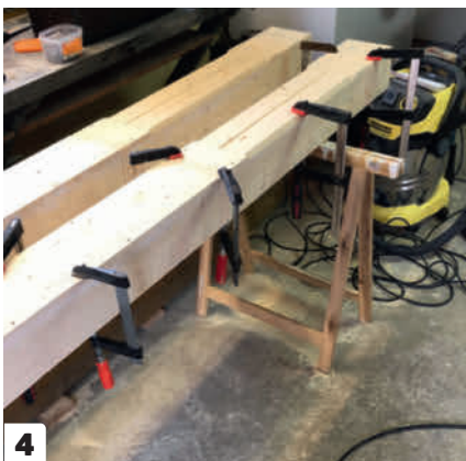
4 De litt kjedelige stolpene blir dekket inn av profilerte bord, som fullender uttrykket. Igjen lages alt i verkstedet før det monteres.
