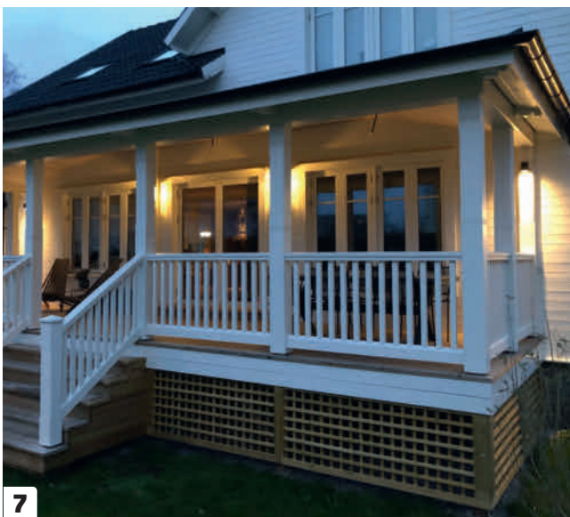
7 Oppbevaringsrommet under verandaen skjules og ventileres gjennom "flettede" fronter. Mønsteret lages av lister og oljes til slutt med en klar treolje. Listene er skåret ut av 22 x 148 mm bord.
