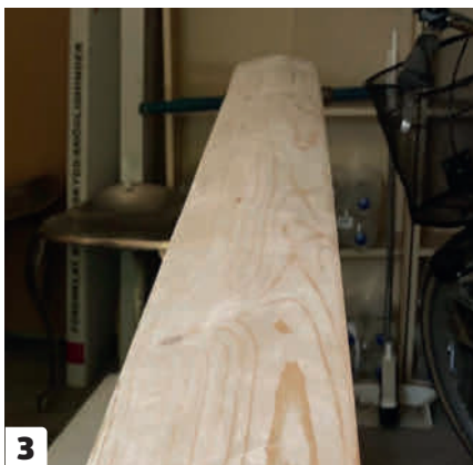
3 Oppå rekkverksmodulene monteres det til slutt en tilpasset håndlist, som avslutter det pent i toppen.
