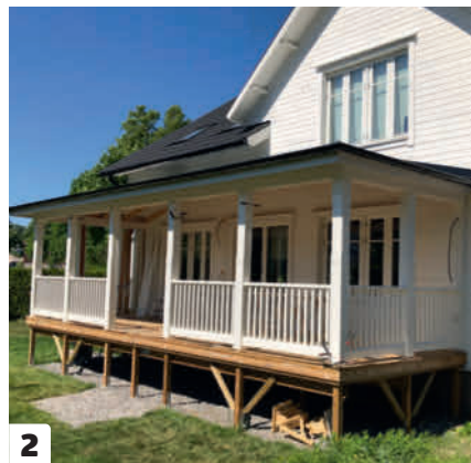
2 Rekkverket settes opp i ferdige moduler. Sørg for å heve det cirka 5 cm over terrassegulvet, så det ikke står i regnvann.
