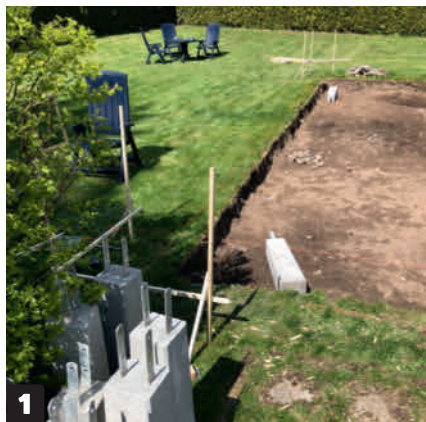
1 Grav vekk det øverste jordlaget, slik at det kan lages en skikkelig bunn i rommet som blir under verandaen.
