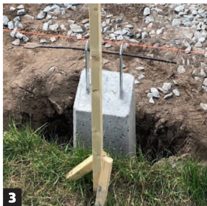
3 Sett "galger" ut for hver rekke fundamentstein, og trekk snorer mellom dem. Da sikrer du at fundamentsteinene står på rekke og ender i samme høyde.
