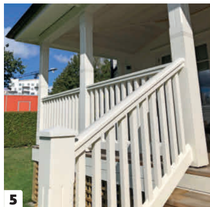
5 Trapperekkverket er skrått, og det kan være vanskelig å finne en prefabrikkert løsning, så her må du uansett i gang med snekkerverktøyet.
