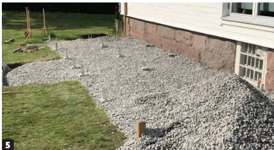
5 Fyll et 5-10 cm lag med pukk (f.eks. 8-11 mm) oppå fiberduken. Det holder duken på plass og danner en jevn bunn i oppbevaringsrommet som kommer under verandaen.
