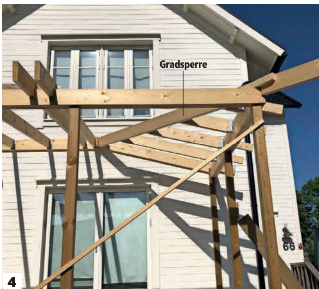
1 Rett opp de loddrette stolpene med støtelistene før du monterer toppsvillen. Skru listene fast på innsiden av stolpene slik at de ikke kommer i veien for toppsvillen.
