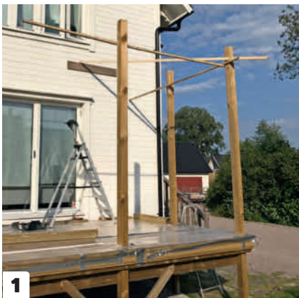
1 Rett opp de loddrette stolpene med støtelistene før du monterer toppsvillen. Skru listene fast på innsiden av stolpene slik at de ikke kommer i veien for toppsvillen.
