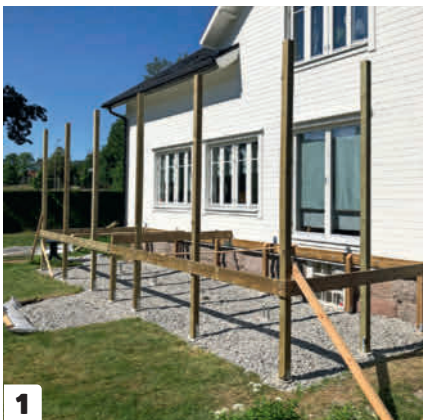
1 Monter stolperne i stolpeskoene , og skru i samme omgang den vandrette rem, der udgør rammen på terrassedækket, fast. Det stabiliserer de lange stolper.
