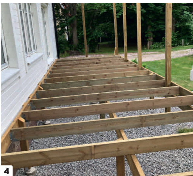
1 Monter stolperne i stolpeskoene , og skru i samme omgang den vandrette rem, der udgør rammen på terrassedækket, fast. Det stabiliserer de lange stolper.
