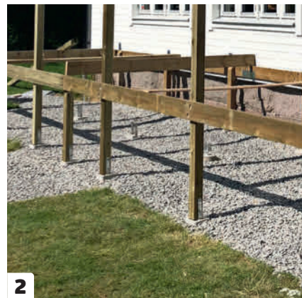
2 Både rem og stolper sættes fast med korte franske skruer. I remmen undersænkes skruerne, så de ikke sidder i vejen for kantbrættet, der monteres senere.
