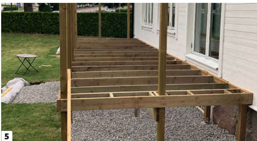
5 Der laves en dobbeltrem i hver ende af bjælkelaget , fordi der skal monteres et bræt hele vejen rundt langs kanten som afslutning på terrassedækket.
