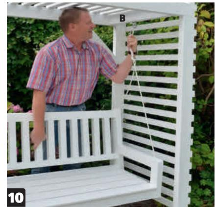
**Heng opp benken i gyngekrokene** i taket. Gyngekrokene er festet i midten av tverrstiverne (B) i taket. Sett stativet fast der det skal stå. For eksempel med et par kraftige vinkelbeslag ned i en steinbelegning.
