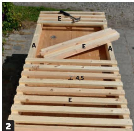
Kledningslektene (E) spikres fast med galvaniserte dykkert. Lag et par avstandsklosser på 48 mm, og sett dem mellom lektene slik at du er sikker på at det blir samme avstand mellom alle.
