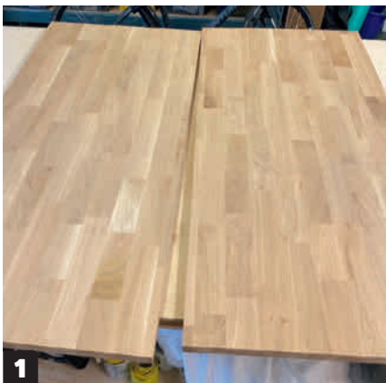
1 Skivan som vi använder är en billig stavlimmad ekskiva, som kan köpas i de flesta byggvaruhus. Bänkskivan är ursprungligen 305 cm lång, men delas på mitten.
