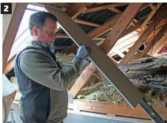
**1. Gipsplatene til lysåpningen** skal inn i falsen i vinduet. Her vist med en trekloss. Det er falsen som styrer hvor langt ut du kan vinkle sidene.
