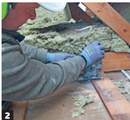
**2** Skjær hullet større med stikksagen. Ta litt om gangen, så bitene ikke blir for tunge. Stikksagen er kun til det grove, så ikke skjær deg helt ut til kanten med den.
