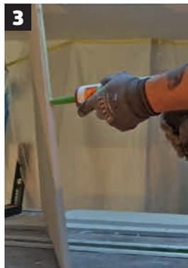
**1. Vi kler lyskassen** med fibergips. Da kan vi nøye oss med ett lag og samtidig få en skrufast overflate. På grunn av skjeve vinkler og takstolene blir det mye tilpassinger. Det er opp for å måle, ned for å skjære og opp for å måle igjen – og igjen.
