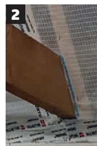
**2. Rundt sperrefoten** må det tettes med dampsperrlim. Nederst skal teipen ha tak i den eksisterende dampsperreren hele veien rundt.
