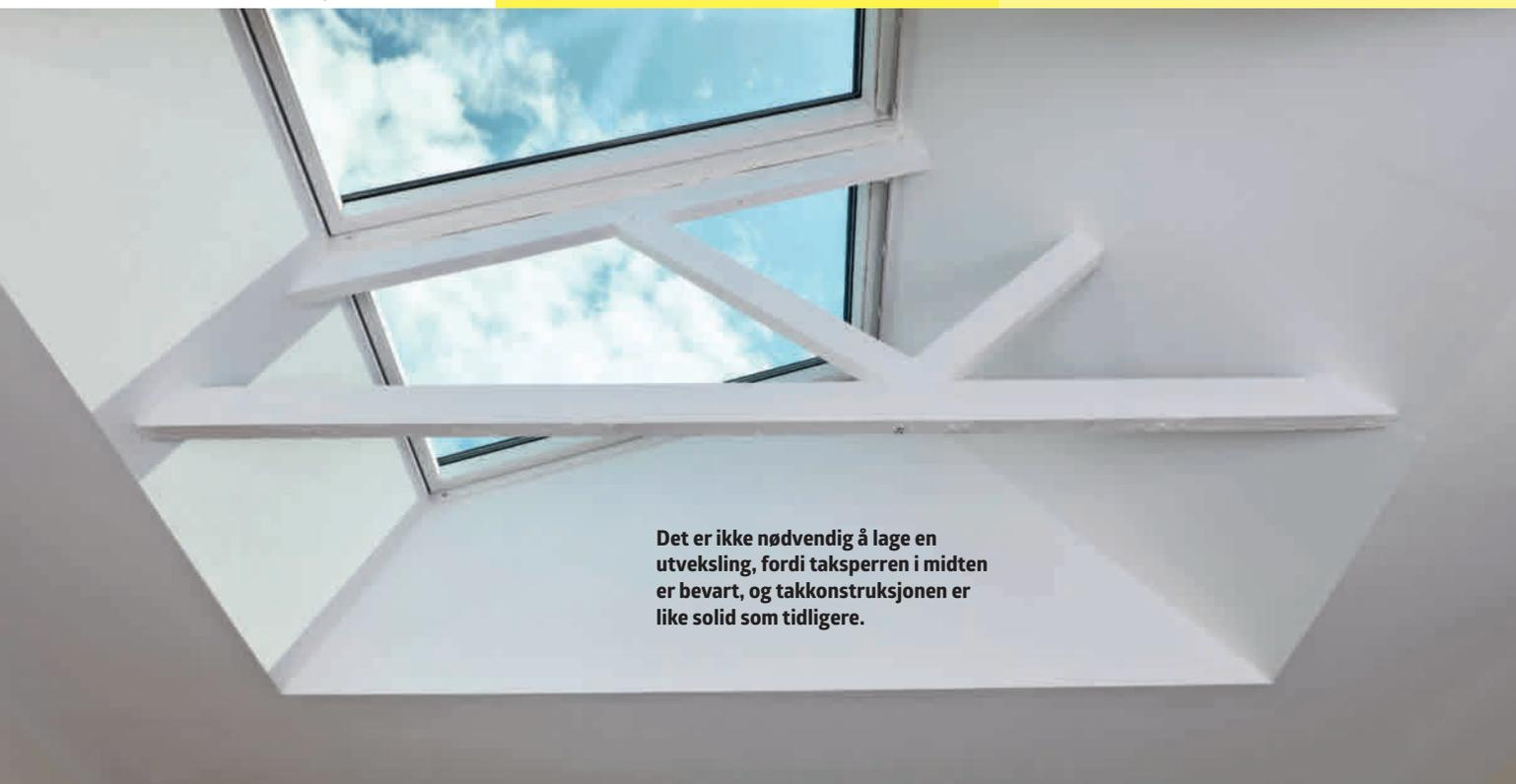
Det er ikke nødvendig å lage en utveksling, fordi takspærren i midten er bevart, og takkonstruksjonen er like solid som tidligere.
