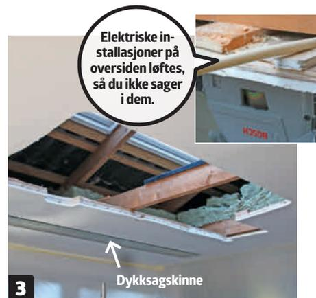
**3** Nå vet vi akkurat hvor kanten skal være. Vi markerer på kantene på hullet på undersiden av himlingen, og skrur fast en dykk-sagskinne i taket med et par gipsskruer.
