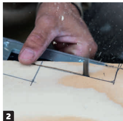
2 Såga först ut hacken på den korta modellen med en sticksåg. Med detta som mall linjerar vi upp en hel vanger (P). Såga ut den och använd den som mall för de återstående nio vangerarna.
