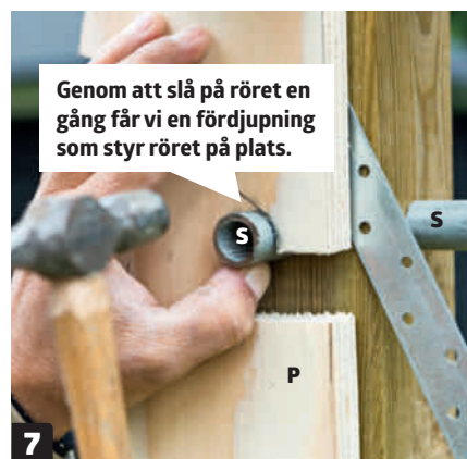
7 Genom att slå på röret en gång får vi en fördjupning som styr röret på plats. Skruva fast upphängningen (S) på stolparna (A och D) så att de passar in i hacken i vangerarna. Skruva fast röret med en bricka och en 50 mm skruv. De 30 mm långa bitarna (S) sågas från ett halvtums vattenrör.
