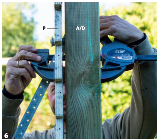
6 Vangerarna (P) spänns upp och skruvas tillfälligt fast på de hörnstolpar (A) och mittstolpar (D) där de ska hänga. På utsidan av varje vanger skruvar vi först fast två tillfälliga 4 mm distanser så att de färdiga luckorna får lite avstånd till stolparna.
