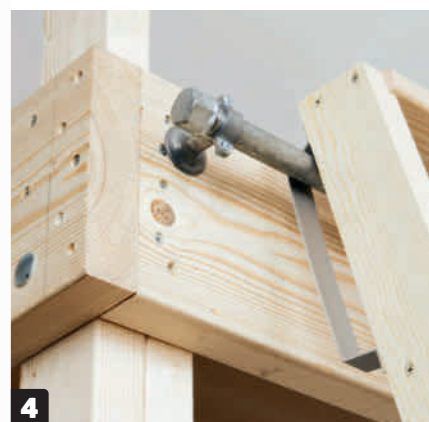
Ruuvaa putkeen sulkuliitin ja kiinnitä putki parven runkoon putkenkannattimilla kuten kuvassa. Ylimmän askelman on tarkoitus olla samalla tasolla parven reunan kanssa.
