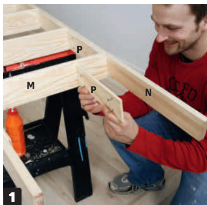
Reisilankkujen väliin asennetaan aluksi yksi askelma (M) ja yksi välikapula (P) molemmille puolille. Välikapulat sahataan 75 asteen kulmassa.
