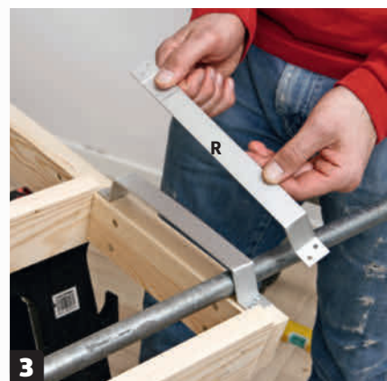
Taivuta alumiinilistat (R) molemmista päistä tämän näköisiksi. Sahaa matalat urat kohtiin, joista raudat on tarkoitus taivuttaa. Ruuvaa ne tikkaiden taakse 4x25 millin ruuveilla.
