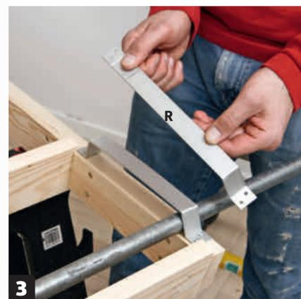
**3 Bøy aluminiumsskinnene (R) i begge ender, slik at du får to beslag som vist. Bruk 5 cm i hver ende til bøyn, og sag et spor der de skal bøyes. Skru dem fast på bakkanten av trappen med 4 x 25 mm skruer.**
