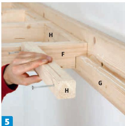
**Monter mellomstykkene (H)** mellom bjelkene med lim og 5 x 80 mm skruer. Lag en prøve først, slik at stykkene blir like lange – det ser penest ut.
