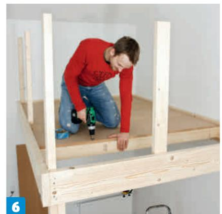
**Sett fast gulvplatene** med 4 x 50 mm selvforankrende skruer. Husk å sage ut, slik at platene passer rundt stolpene.
