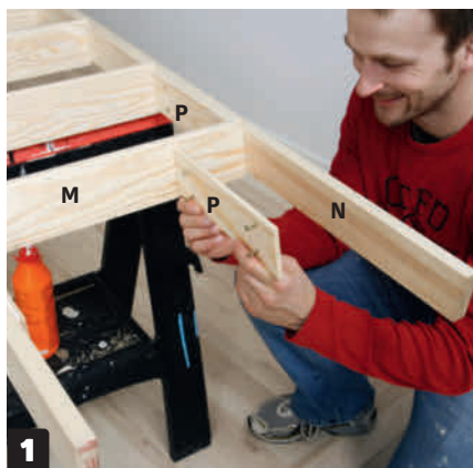
1 Mellem vangerne sættes først ét trin (M) og så et mellemstykke (P) i hver side. Mellemstykkerne er skåret i 75° smig.
