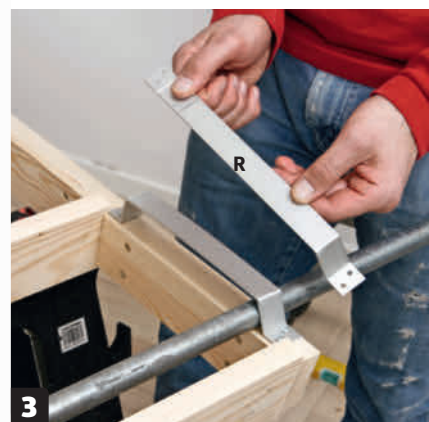
3 Buk aluskinnerne (R) i begge ender, så du får to beslag som vist. Brug 5 cm i hver ende til ombuk, og sav en rille i skinnerne der, hvor de skal bukkes. Skru dem på bagkanten af trappen med 4 x 25 mm skruer.
