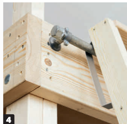
4 Skru en slutmuffe på stålrøret, og gør det fast til rammen med to rørbærere som vist, så øverste trin på trappen flugter med gulvet på hemsen.
