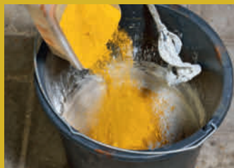
Häll i färg och rör om så all betong färgas. Tillför eventuellt mer vatten.
