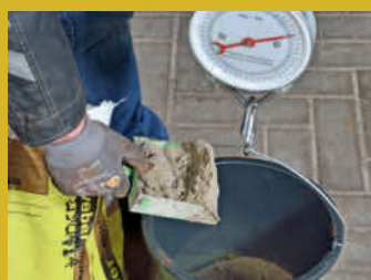
Cement och ballast (sand/grus) vägs upp i en hink.
