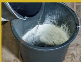
Ballast och cement blandas, och vatten hälls i.
