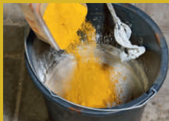
Rør inn fargen slik at all betong farges. Tilfør eventuelt mer vann.
