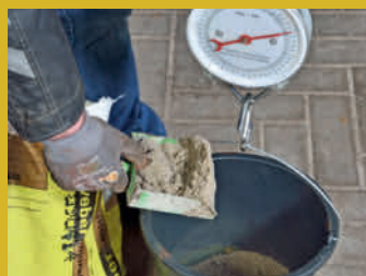
Sement og tilslag (sand/grus) veies opp i et spann.
