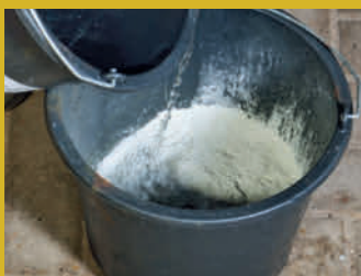
Tilslag og cement blandes, og der hældes vand i.
