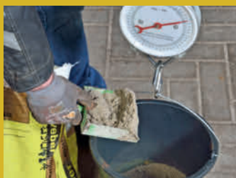
Cement og tilslag (sand/grus) vejes af i en spand.
