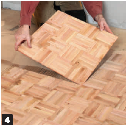
4 Paina laatta tiiviisti nurkkaan, jotta se tarttuu kunnolla kiinni viereisiin laattoihin ja alla olevaan liimaan.
