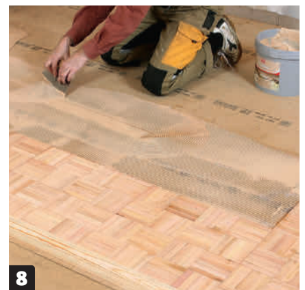
8 Irrota toinen ohjainlauta ja asenna viimeiset laatat. Paina laatta taas nurkkaa vasten, kun aloitat, jotta saumoista tulee niin suorat kuin mahdollista.
