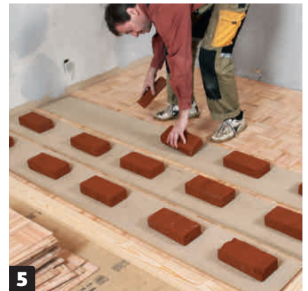
5 Paina laatat kiinni liimaan tiilillä, kunnes laatat tarttuvat kiinni. Lattia kannattaa suojata levynpalasilla siitä huolimatta, että se hiotaan myöhemmin.
