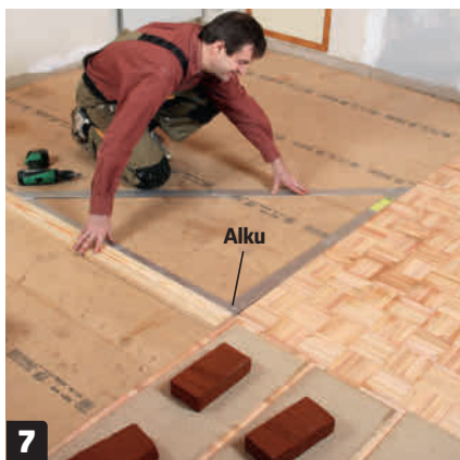
7 Tarkista vielä kerran ohjainlaudan kulma. Aloita asentaminen nurkasta, jossa lattia ja ohjainlauta kohtaavat.
