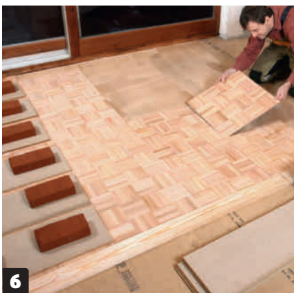
6 Irrota lyhyempi ohjainlauta ja jatka laattojen asentamista samalla tavalla kuin aiemmin. Muista jättää sentin levyinen rako joka puolelle.
