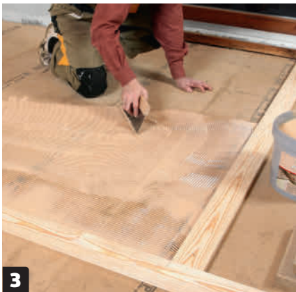
3 Levitä liima hammaslastalla pienelle alueelle kerrallaan, sillä liima kuivuu melko nopeasti. Älä levitä liimaa ohjainlautoihin. Jos niin käy, ne eivät irtoa toisistaan.
