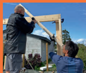
Väliaikaiset vinotuet pitävät huolen siitä, että runko pysyy suorassa rakennusaikana.
