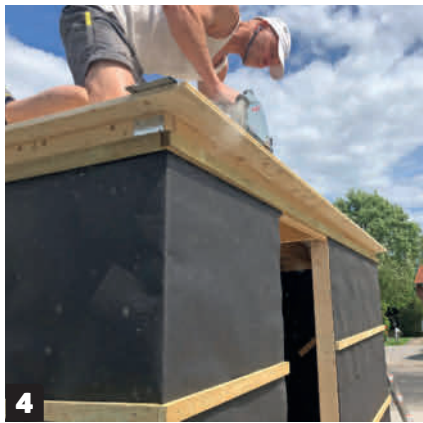
4 Levyjen reunat sahataan upotussahalla ja ohjainkiskolla. Levyjen pitää ulottua joka puolella 10 senttiä yläpalkin linjan yli.
