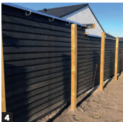
4 Vajan takapuolelle asennetaan vinovuorilaudat, joiden koko on 13/24 x 110 millia. Ne on maalattu mustiksi ennen asentamista. Seinä jää kokonaan aidan taakse, jonka tolpat näkyvät kuvassa.
