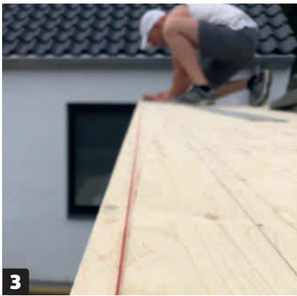
3 21 milliiä paksut kattovanerit kiinnitetään 5x60 millin ruuveilla. Kaikki saumat tulevat kattopalkkien tai poikkipalkkien päälle. Levyjen sahauslinjat merkitään värilangalla.
