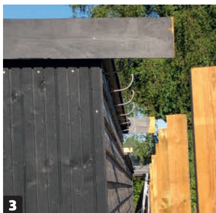
3 Kourukoukut asennetaan siten, että kouru kallistuu noin sentin metrin matkalla syöksytorvea kohti. Koukut asennettiin noin 60 sentin välein.
