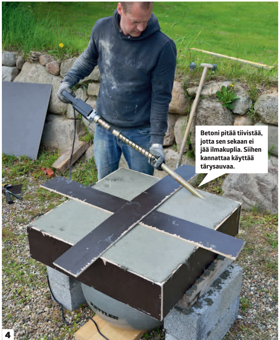
4 Vahvista muotti ja tiivistä betoni. Ruuvaa muotin päälle ristiin kaksi levympalasta, ennen kuin tiivistät betonin. Täräyttämisen tekee betonista juoksevampaa ja painaa sitä laitoja vasten. Siksi muottia pitää vahvistaa.
