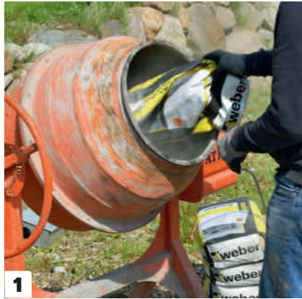
1 Tässä betonin sekoittamiseen käytetään betonimyllyä. Voit sekoittaa betonin myös kottikärryssä porakoneella ja vispilällä.
