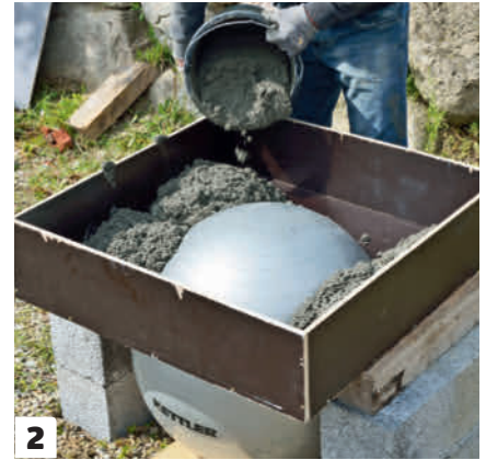
2 Kaada betoni muottiin. Lisää betonia vähän kerrallaan ja levitä sitä tasaisesti joka puolelle. Tiivistä betoni sitä mukaa niin hyvin kuin pystyt. Täytä muotti reunoille asti.
