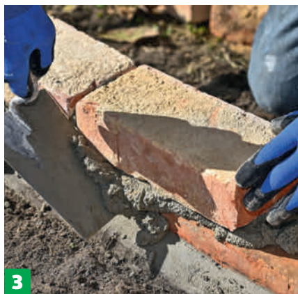
3 Kaavi ylimääräinen laasti pois heti, kun olet painanut tiilen paikalleen. Pyyhkäise laasti pois ja heitä se takaisin paljuun laastikauhalla.
