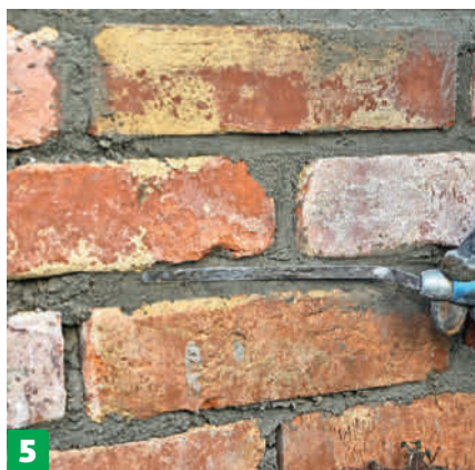
5 Tasoita saumat kapealla saumaimella. Se painaa laastin saumoihin ja tekee siistin ja yhtenäisen vaikutelman.
