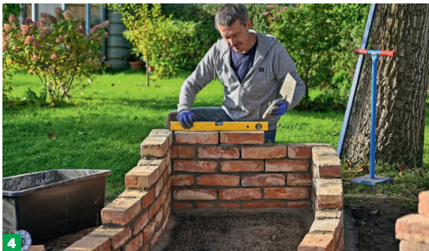
2 Levitä ensimmäisten tiilien päälle kunnolla laastia. Paina tiili toisen rivin ensimmäistä, nurkassa olevaa tiiltä vasten. Koputa tiili samalle tasolle ensimmäisen kanssa.
