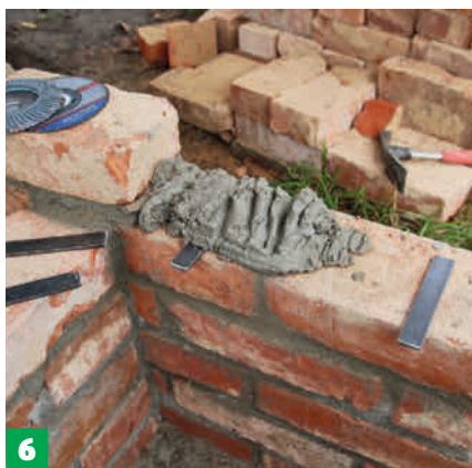
6 Jos haluat tehdä hyllyt, asenna raudat saumoihin haluamallasi korkeudelle. Levitä päälle reilusti laastia.
