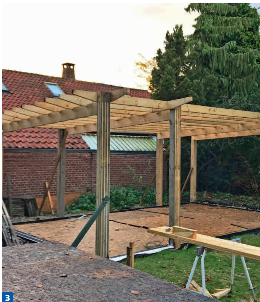
Fordi det skal være plater og takbelegg på taket , er det maksimalt 60 cm mellom taksperrene. De underliggende åsene er kraftige og dimensjonert etter det lange spennet de har her. Sperrene skråskjæres i endene for å gi takutstikket et lettere uttrykk.
