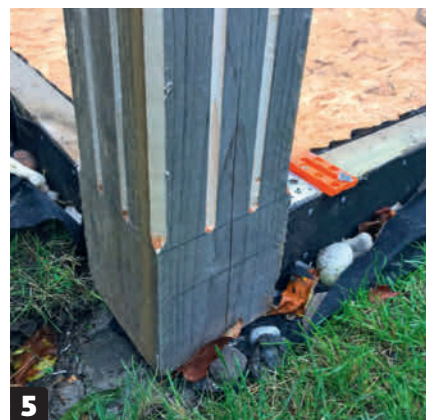
5 Den kraftige stolpen plasseres oppå den korte på punktfundamentet. Maler du stolpene før de monteres, er du sikker på å få beskyttet hele den nederste og utsatte delen av stolpen.
