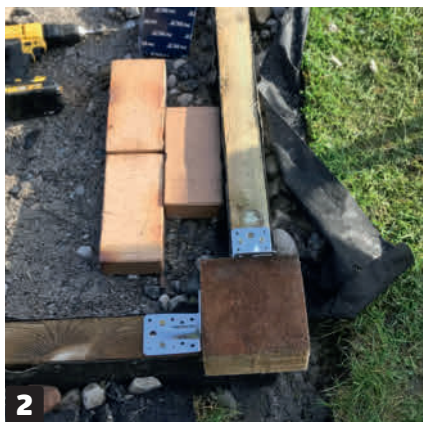
2 Her brukes trykkimpregnerte bjelker som bunnsviller. De korte stolpene i hjørnene står på punktfundament, og stikker ikke mer enn 10 cm over bakken.
