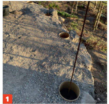
Kaiva kuopat pisteperustuksille. Kupoli rakennetaan 20 tukipisteen varaan. Niiden pitää olla yhtä kaukana toisistaan. Tässä vaiheessa ei voi olla liian tarkkana.
