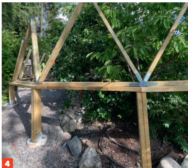
Asenna aluksi nelisakaraiset raudat. Kun alalankut ovat vaakasuorassa tolppien kohdalla, voit aloittaa kupolin rakentamisen. Asenna aluksi nelisakaraiset raudat tolppien kohdalle ja ruuvaa viistot pystylankut kiinni alalankkuun.
