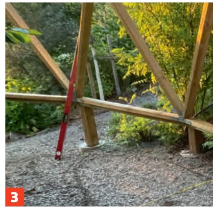
Asenna tolpat ja vaakalankut. Tämä kupoli rakennetaan kaltevalle paikalle, mutta korkeuserot tasoitetaan sahaamalla tolpat poikki samalta korkeudelta.
