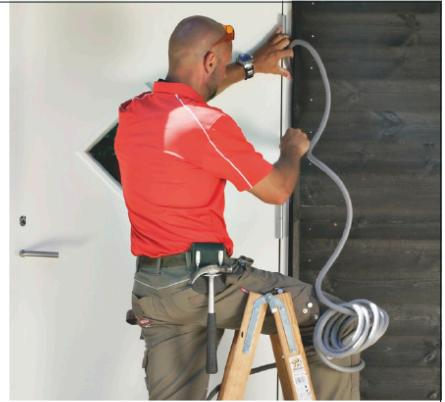
**2** Så skal det legges inn fugebakstopp. Hvis fugen er 12-14 mm, passer det med et 16 mm fugebånd. Er veggjen skjev, kan du bruke forskjellige tykkelser fugebånd.
