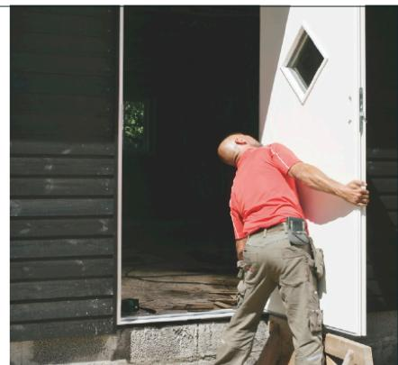
**1 Heng på dørbladet.** Du kan bare se ett hengsel om gangen, men døren skal passe på alle tre samtidig. Hold derfor øye med det øverste hengselet, og tilpass det nederste med venstre hånds fingre.
