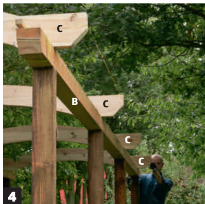
Överliggarna (C) läggs på bärlinorna (B) och rättas in efter ett snöre. Överliggarna fästs med två 6 x 150 mm skruvar på varje sida. Skruvarna monteras i hål som är 5 cm djupa och 16 mm breda.
