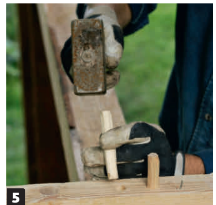
Skruvarna döljs med tappar med spetsiga bitar av 16 mm rundstav. Först har tapparna doppats i lim. Överskjutande tapp sågas av med en fogsav.
