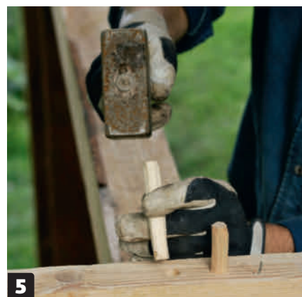
5 Skruerhullene proppes igjen med tilspissede biter av 16 mm rundstokk. I forkant er rundstokkene smurt med lim. Det overskytende sages vekk med en hondsag.
