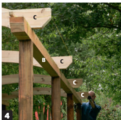
4 Overliggerne (C) legges opp på svillene (B) og rettes inn etter en snor. De festes med to 6 x 150 mm skruer i hver side. Skruene monteres i 5 cm dype, 16 mm brede hull.
