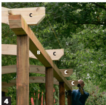
Overliggerne (C) lægges op på remmene (B) og rettes ind efter en snor. Overliggerne fastgøres med to 6 x 150 mm skruer i hver side. Skruerne monteres i 5 cm dybe, 16 mm brede huller.
