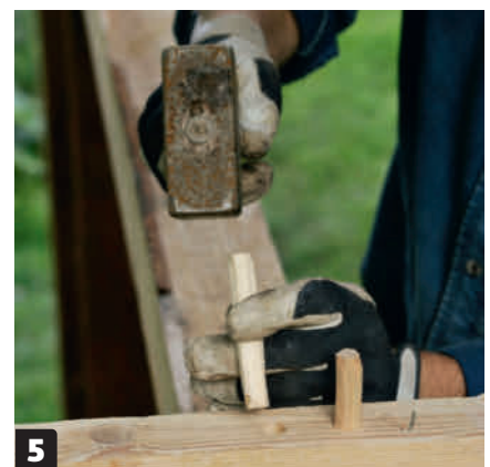
Skruerne proppes af med tilspidsede stykker af 16 mm rundstok. Forinden er rundstokkene smurt med lim. Overskydende prop saves af med en fuksvans.
