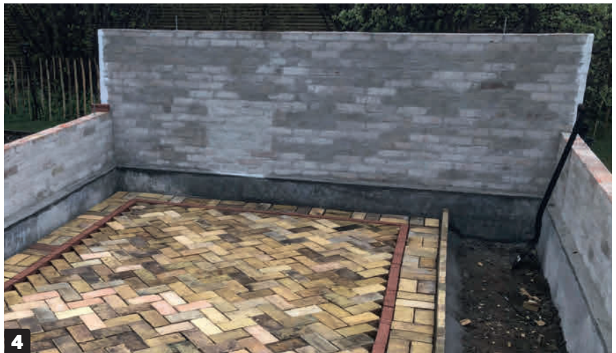
4 Rappaa sokkeli sisäpuolelta. Se on helppo ja kestävä ratkaisu, joka ei maksa paljon. Sekoita rappauslaasti valmistajan ohjeen mukaan
