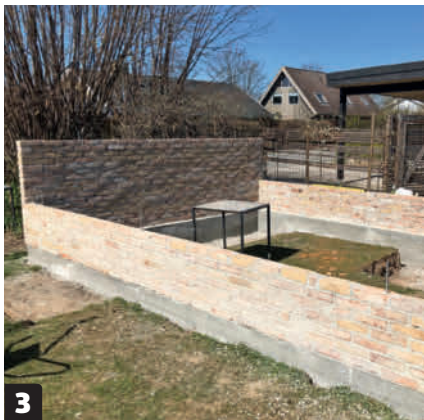
3 Takaseinästä tehdään vähän korkeampi (tässä 10 kerrosta), jotta naapurin puoleiseen seinään ei tarvita niin paljon lasia.
