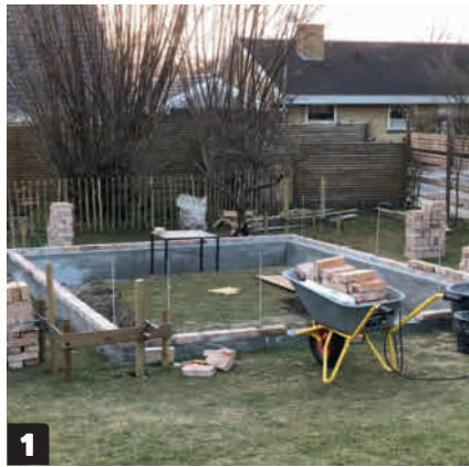
1 Levitä sokkelin päälle huopakaistale, jotta kosteus ei nouse sokkelista puuhun. Lado tiilet kokeeksi, jotta näet, millainen kuvio ja saumanleveys näyttää parhaalta.
