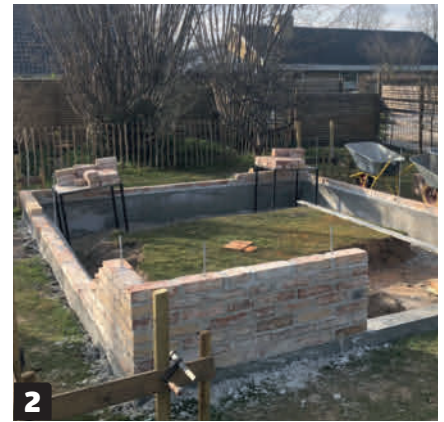
2 Muuraa aluksi yksi kulma, jotta saat rivit samaan korkoon kahdella seinällä. Kierretangot muurataan tiiltien sisään. Tankoihin kiinnitetään rungon alaojhauspuut.
