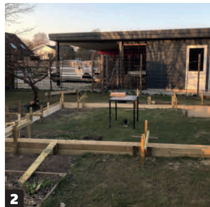
2 Gräv en ränna som är minst 90 cm djup (till frostfrit djup) och gör sedan en gjutform som sockeln kan gjutas efter. Gjutningen ska härda i ca 3 veckor.
