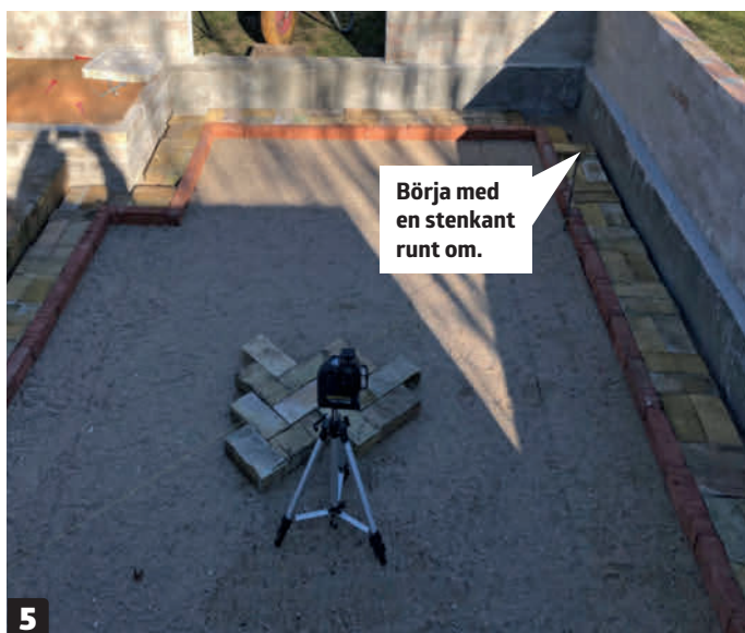
5 Packa och jämna till sättsand i orangeiet, så att den är redo för beläggning. Här läggs de återvunna tegelstenarna.
