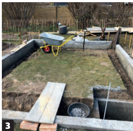
3 Invändigt ska en ränna grävas längs den gjutna sockeln. Det är nödvändigt, så att vattnet från de växtsäckar som senare ska placeras där, kan ledas bort.
