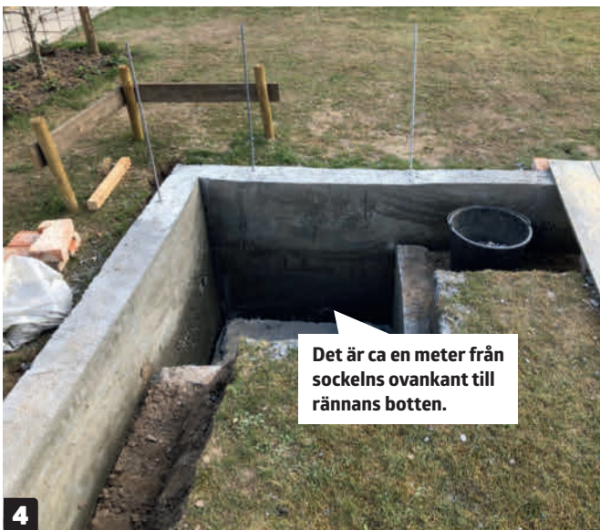
4 När randfundament och sockel torkat gräver vi ett extra djupt hål i orangeiets ena hörn. Det ska fungera som ett naturligt kylskåp. Kanten på kylskåpet muras upp senare.
