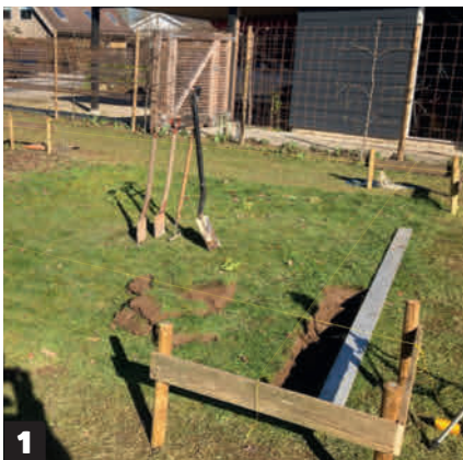
1 Markera var fundamentet ska vara genom att sätta profiler i hörnen, som du kan dra snöre mellan.
