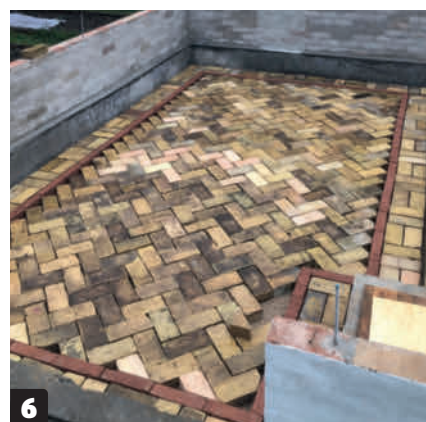
6 I det avgränsade området läggs stenarna i fiskbensmönster. Lägg alla hela stenar först och anpassa alla de små bitarna till sist.
