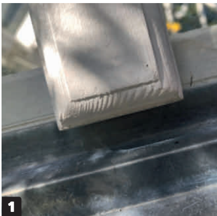
1 Glasslistene, som skal holde alle vinduene på plass, har en profil på kantene. Profilen er laget med en overfres.
