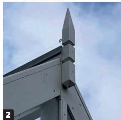
2 I hver av gavlene er det laget en "konge". De pynter ikke bare opp, men har også en funksjon. Det er nemlig spent ut en snor mellom dem for å hindre at fugler setter seg på mønet.
