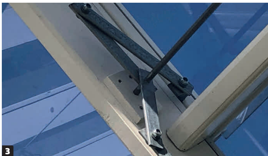
3 Det er smart å lage noen av takvinduene åpningsbare. Her er det til og med laget en smart anordning, slik at vinduene kan åpnes og lukkes ved hjelp av et håndtak.
