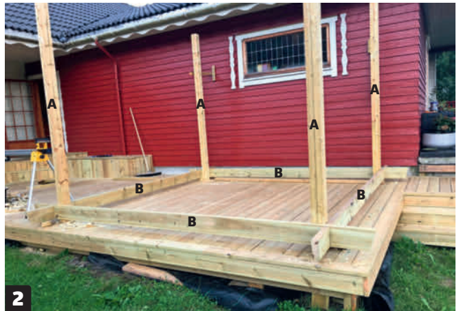
2 Sahaa kantavat palkit (B) ja asenna ne aluksi terassille tolppien (A) ympärille. Sen jälkeen voit mitata helposti tuplapalkit, jotka asennetaan poikittain kantavien palkkien päälle. Tolppien viereen pitää tehdä lovet, jotta palkit tarttuvat kunnolla kiinni toisiinsa.
