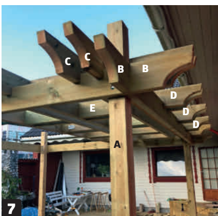
7 Asenna palkit (C) ja palkinpäät (D) kantaviin palkkeihin (B). Upota lovet palkkeihin ja säädä tuplapalkit ja palkinpäät tarkasti yhtä kauas toisistaan. Kiinnitä osat pitkillä ruuveilla.
