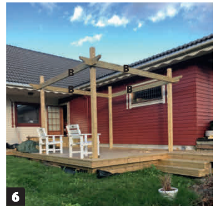
6 Kiinnitä kantavat palkit (B) tolppiin pulteilla ja muttereilla. Pidä huoli, että palkit ovat vaakasuorassa. Palkkien päissä on samanlaiset kaaret kuin osissa (C) ja (D)
