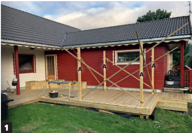
1 Asenna tolpat (A) pisteperustuksissa oleviin tolppakenkiin. Tue tolpat väliaikaisesti laudoilla, jotta ne pysyvät pystysuorassa siihen asti, että palkit ovat paikoillaan.
