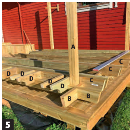
5 Piirrä palkkien (C) ja palkinpäiden (D) paikat kantaviin palkkeihin (B). Lovien pitää olla niin isoja, että osat uppoavat kantaviin palkkeihin. Kun olet valmis, nosta palkit (C) ja palkinpäät (D) pois.
