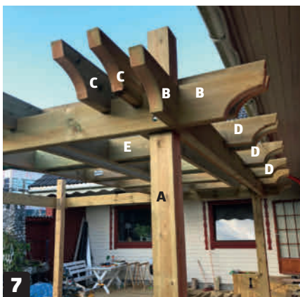
7 Monter sperrer (C) og sperreender (D) til toppsvillene (B) . Legg dem ned over toppsvillene og juster avstanden slik at de doble sperrene og sperreendene sitter nøyaktig. Fest dem med lange skruer.
