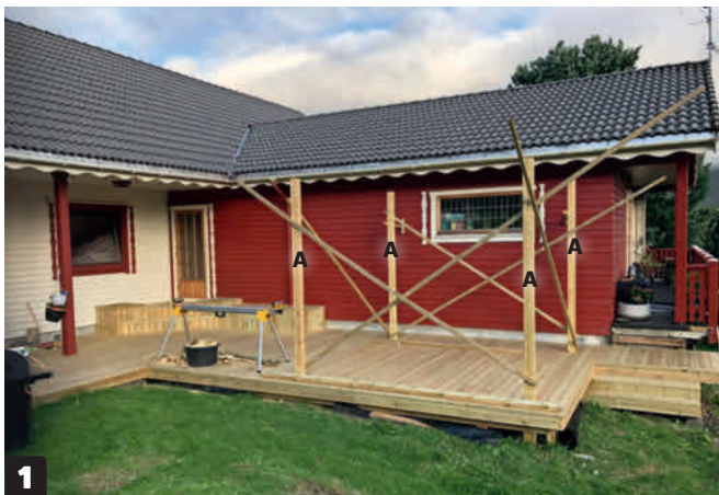
1 Monter fire stolper (A) i stolpesko i de støpte punktfundamentene. Stolpene holdes midlertidig med lekter. Da holder de seg på plass til toppsvillene er satt fast.
