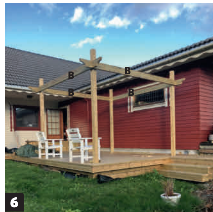
6 Sett fast toppsvillene (B) øverst på stolpene med bolter, slik at taket på pergolaen sitter i ønsket høyde. Sørg for at toppsvillene sitter helt rett. Endene er også skåret til med samme runding som sperrene.
