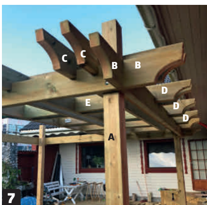
7 Montér spær (C) og spærrender (D) til remmene (B) . Lad hakkene glide ned over remmene, og justér afstandene, så de dobbelte spær og spærrender sidder præcist. Fastgør så med lange skruer.
