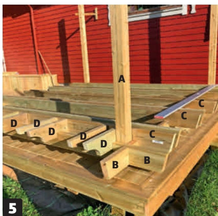
5 Tjek placeringen af spær (C) og spærrender (D) på remmene (B). Hakkene skal være store nok til, at de kan sidde fast på remmene. Hvis ikke, må du rette hakkene til. Når du er tilfreds, fjernes spær- og spærrender.
