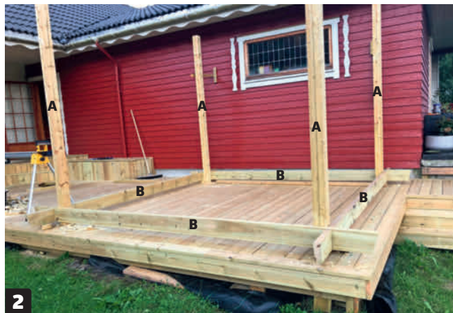
2 Sav remmene (B) til , og placér dem i første omgang på terrassen rundt om stolperne (A). Så kan du nemt komme til at måle op til de dobbelte spær, der skal monteres på tværs af remmene. Der skal laves hak ved stolperne, så remmene griber godt fat i hinanden.
