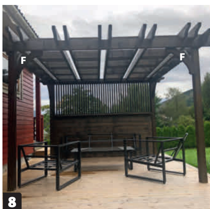
8 Pergolaen får sort træbeskyttelse , så træet holder længere. Mal evt. delene, inden de skrues fast. Her monteres også skræstivere (F) øverst på stolperne med bolte. Det giver ekstra styrke og stabilitet.
