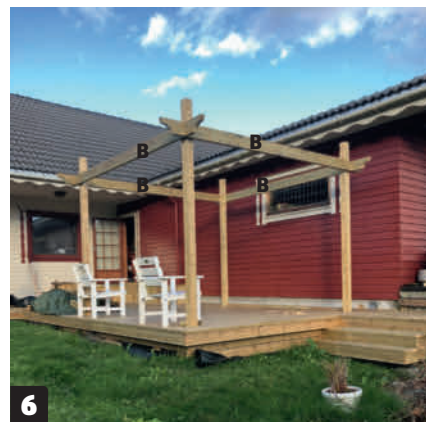
6 Fastgør remmene (B) foroven på stolperne med bolte, så pergolaens tag sidder i den ønskede højde. Sørg for, at remmene sidder helt lige. Enderne på remmene er også skåret til med samme runding som spærrene.
