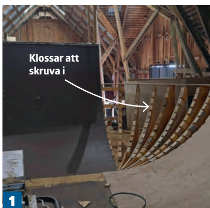
Skruva klossar på sidan av vangerna som ska bilda hörnet. Det ger ett bra skruvunderlag.
