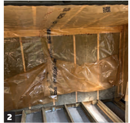
2 Nido höyrnsulkumuovi kattoon ja anna sen jatkua seinille ja lattialle. Tiivistä kaikki saumat höyrnsulkuteipillä.
