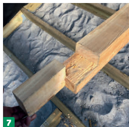
7 Rästystä alle asennetaan lehtikuusi-tolpat. Niihin sahataan lovet yläpalkkia ja kattopalkkia varten. Liitoksesta tulee hieman erikoinen mutta todella luja. Rästystä tuetaan aluksi väliaikaisilla lankuilla.
