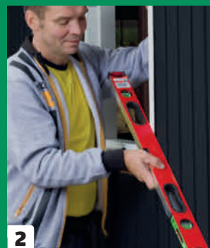
Asenna ikkuna siten, että sen pinta jää ulkovuorilautojen sisäpuolelle.
