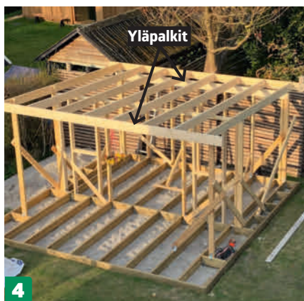
4 Kun etu- ja takapalkit ovat paikoillaan, niiden väliin asennetaan kattopalkit. Ne asennetaan tasaisin välein korkeintaan 60 sentin jaolla.
