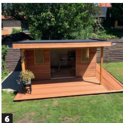
6 Laudat asennetaan eri suuntiin, jotta terassiin ei tarvitse tehdä pituussuuntaisia jatkosaumoja.
