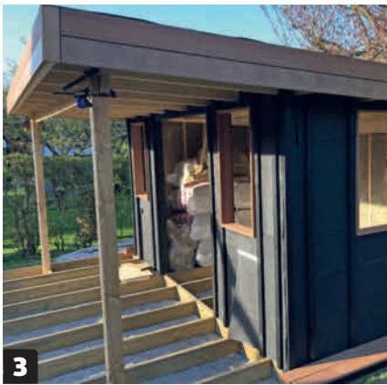
Taita pahvi ikkuna-aukkoon ja asenna smyygilaudat. Voit maalata koolausrimat mustiksi, jotta ne eivät pilkistä ulkovuorilautojen välisistä raoista.
