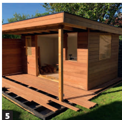
5 Asenna terassilaudat ylipitkinä ja sahaa ne poikki samalla kertaa käsisirkkelillä tai upotussahalla. Reunasta tulee tasainen, ja terassin ympärille on helppo asentaa reunalauta.
