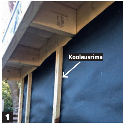
Asenna runkotolppien päälle tuulipahvit ja jokaisen runkotolpan kohdalle koolausrima.
