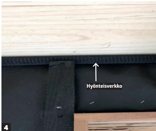
Ampiaiset ja muut hyönteiset sekä tuiskulumi pysyvät pois kattorakenteista, kun seinän ja katon rajaan asennetaan hyönteisverkko.
