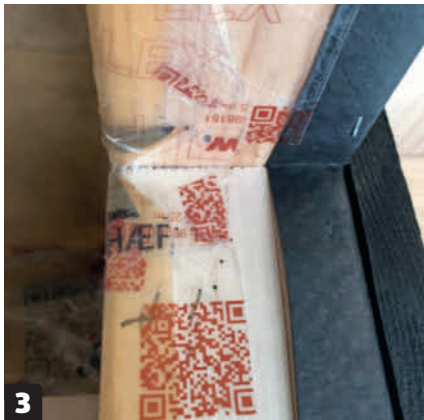
3 Leikkaa muovin reunat vinoon ikkunoiden kohdalla, jotta voit taistaa ja teipata muovit kiinni lankkuihin.
