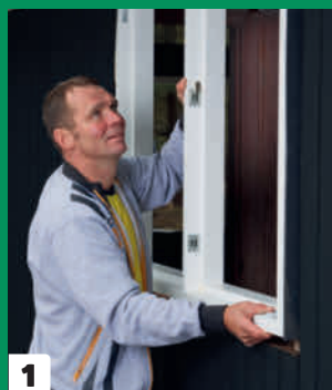
Asenna ikkuna aukkoon ja kiilaa se suoraan. Jätä karmin ympärille 12 millin raot.
