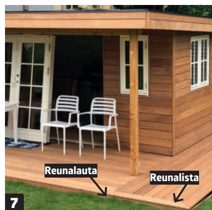
7 Asenna ikkunat ja ovet pari senttiä seinälinjan sisäpuolelle. Eristä raot ja viimeistele ulkopuoli silikonilla.
