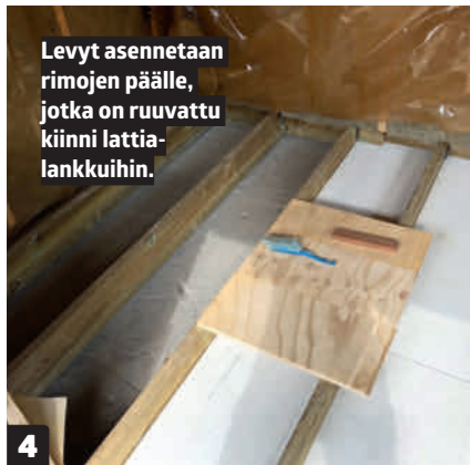
4 Levyt asennetaan rimojen päälle, jotka on ruuvattu kiinni lattia-lankkuihin. Asenna tuulensuojalevyt lattialankkujen väliin. Ruuvaa lankkuihin aluksi kapeat rimat, jotta levyt eivät putoa maahan. Jätä levyjen päälle 50 millia tilaa eristeille.
