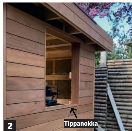
2 Kohdista laudat niin, että ikkunan alla oleva lauta on kokonainen. Se näyttää tyylikkäältä.
