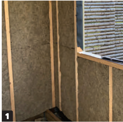
1 Asenna villalevyt limittäin siten, etteivät niiden väliset saumat ole samassa linjassa.
