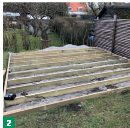
2 Fäst tvärgående bjälkar i syllen. Bjälkarna stötts på mitten av stolpbeslag som gjuts fast i betong.
