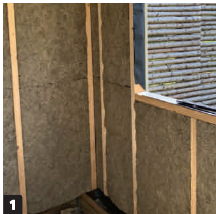
1 Förskjut de liggande skarvarna i isoleringen från fack till fack, så att de inte sitter på samma höjd runt om.
