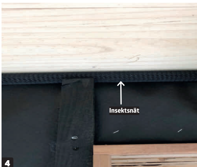
För att slippa flygsnö, getingar och andra skadedjur sätts ett ventilerat insektsnät mellan väggens ovansida och taket.
