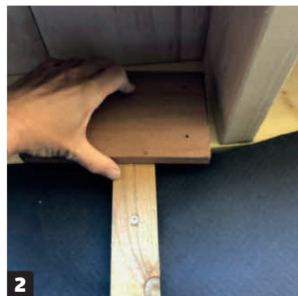
2 Sätt extra spikläkt mellan sparrarna, så att det finns något att fästa panelen i.
