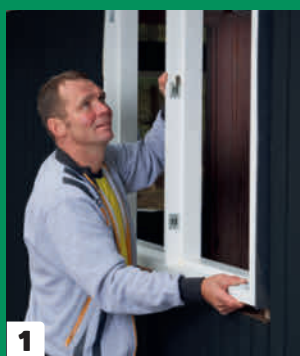
1 Sätt in fönsterramen, klossa upp och kolla så att det är 12 mm luft runt om.
