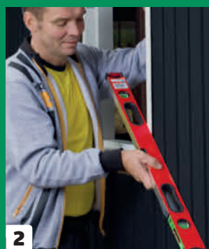
2 Se också till att dra in ramen jämfört med fasadpanelen.
