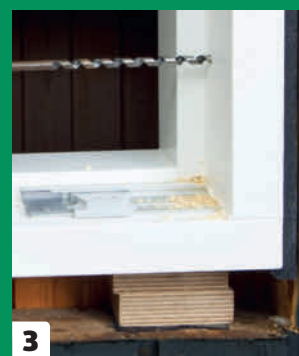
3 När fönstret sitter som det ska, kan det skruvas fast.
