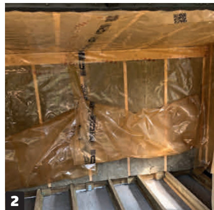
2 Klamra fast ångspärren i taket och låt den fortsätta ner på väggarna och vidare på golvet. Tejpa alla skarvar med ångspärrstejp.
