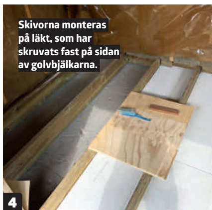
4 Lägg ut ett lager vindspärr mellan golvbjälkarna. De monteras på läkt som först har skruvats fast på sidan av bjälkarna. Lägg skivorna med 50 mm till ovankanten, så att det finns plats för isolering.
