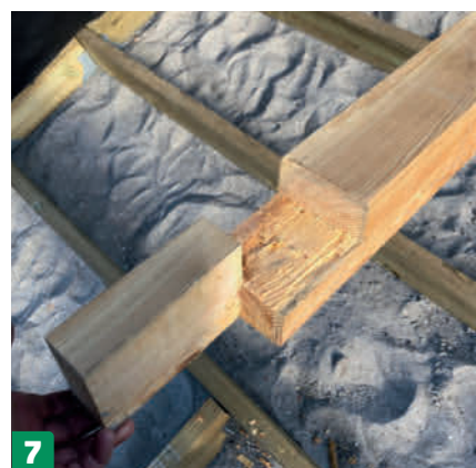
7 Utsprånget bärs upp av stolpar av lärkträ. I dem sågas ut för både hammarband och sparre. Det ger ett lite speciellt, men väldigt starkt snitt. Först stötts det dock av tillfälliga regler som senare byts ut.
