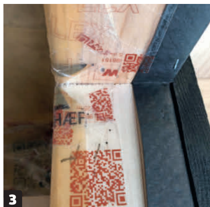
3 Skär ångspärren diagonalt så att den kan vikas in i fönsteröppningen, och tejpa sedan fast den på reglarna.
