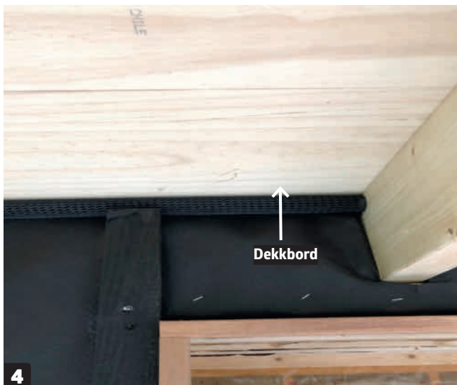
4 For å unngå snøføyk og skadedyr inn i taket, monteres det et dekkbord mellom alle taksperrene.
