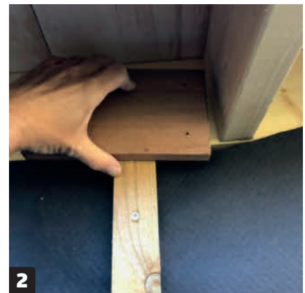
2 Sett opp ekstra avstandslist mellom sperrene, som underlag til kledningen.
