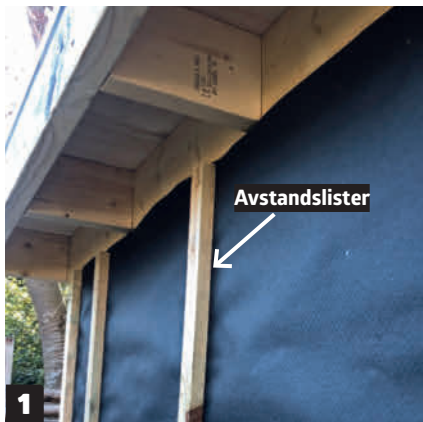
1 Lukk den utvendige delen av veggen med vindpapp, og monter avstandslist utenpå hver av de loddrette stenderne.
