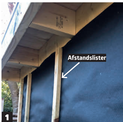
1 Luk den udvendige del af skelettet af med vindpap, og monter afstandslister ud for hver af de lodrette reglar.
