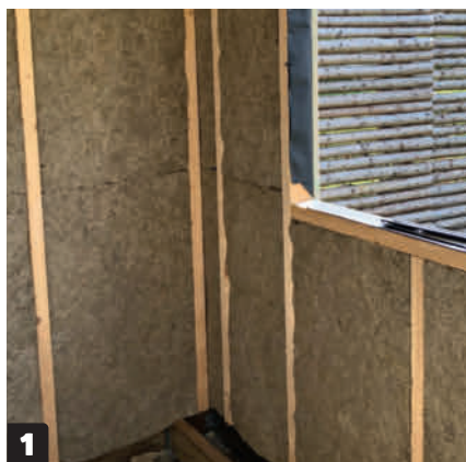
1 Forskyd de vandrette samlinger i isoleringen fra felt til felt, så de ikke sidder i samme højde hele vejen rundt.
