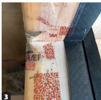
3 Skær dampspærren skråt, så den kan vippes ind i vindueshullerne, og tape den så fast til reglarne.
