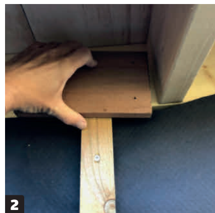
2 Sæt ekstra afstandslister op mellem spærrene, så der er underlag til beklædningen.
