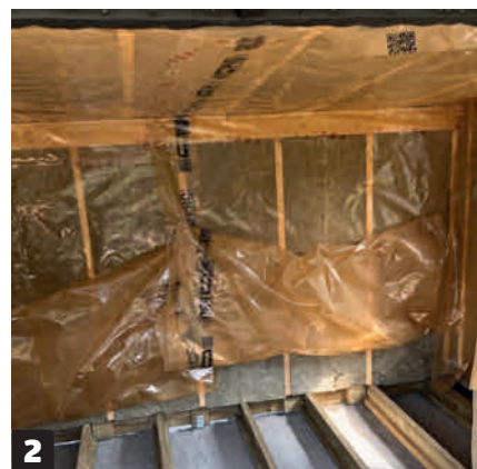
2 Klips dampspærren op i loftet, og lad den fortsætte ned på væggene og videre på gulvet. Tape alle samlinger med dampspærre-tape.
