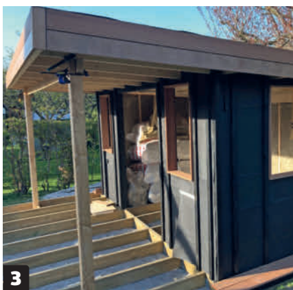
3 Fold pappet ind i vindueshullet, og afslut det med en ramme af beklædningsbrædder. Afstandslisterne kan med fordel males sorte. Så er de ikke synlige gennem beklædningen.
