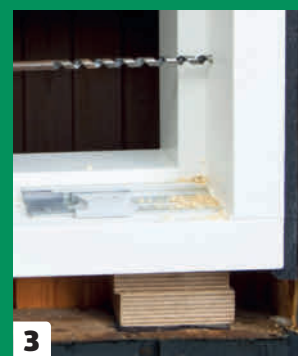
3 Når vinduet sidder, som det skal, kan det skrues fast.
