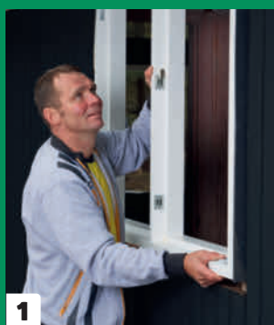
1 Sæt vinduesrammen, klods op, og tjek, at der er 12 mm luft hele vejen rundt.
