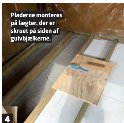
4 Pladerne monteres på lægter, der er skruet på siden af gulvbjælkerne. Læg et lag vindstop-plader ud mellem gulvbjælkerne. De monteres på lægter, der forinden er skruet fast på siden af bjælkerne. Hold pladerne 50 mm fra overkanten, så der er plads til isolering.
