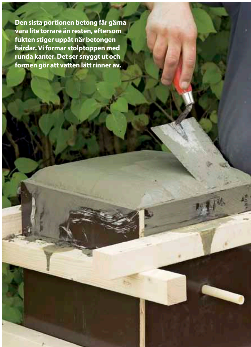
Håll betong i gjutformen.
