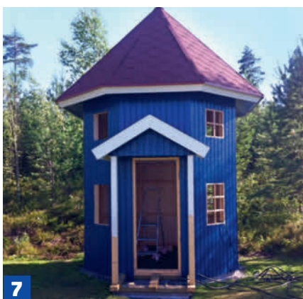
Vindfanget er bygget op af stolper og lægter og er forsynet med et lille tag.
