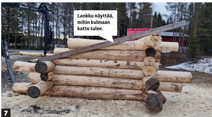
7 Kun kaikki päätyhirret ovat paikoillaan , niiden pinta sahataan katon suuntaiseksi. Katon kulma merkitään ylimpiin hirsii pitkän lankun avulla. Sen jälkeen ylimääräiset sahataan pois moottorisahalla.
