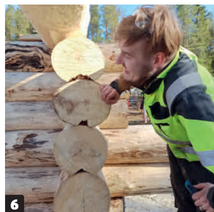
6 Hirsien päissä näkyvät kolot näyttävät, kuinka yksinkertaisia liitokset ovat. Yhdeltä puolelta lovettuja hirsisalvoksia sanotaan koirankauloiksi.
