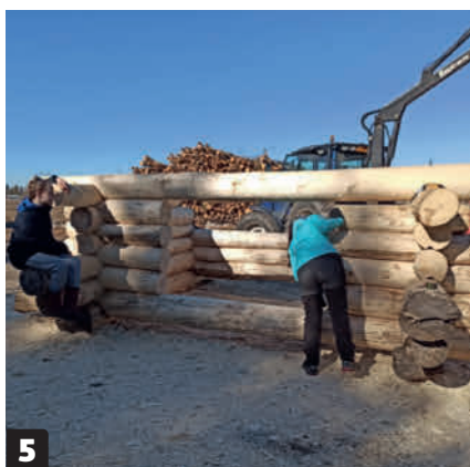
5 Pitkän seinän ylin hirsä asennetaan sen jälkeen, kun päädyissä on kuusi hirsikertaa. Silloin selviää, ovatko seinät yhtä korkeita.
