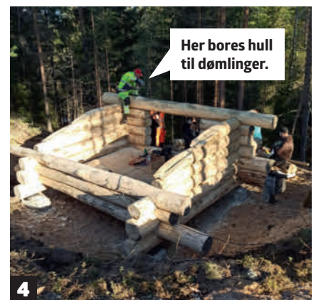
4 Alle stokkene låses med dømlinger etter at de er lagt på plass. Dømlingene er treplugger av 28 mm kosteskaft, som det forbores til før de bankes ned i stokkene.
