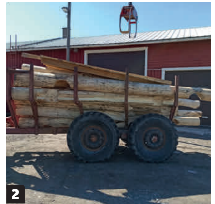
2 Laftekassen plukkes ned med kran etter at stokkene er merket, slik at vi vet hvilke som skal sitte hvor. Her får vi hjelp av utstyr som egentlig brukes til å frakte tømmer ut av skogen.
