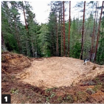
1 Det er ryddet en plass i skogen, der den ferdige gapahuken skal stå. Jobben er gjort med gravemaskin.
