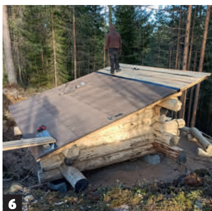
6 På toppen legges takbelegg i ett lag. Takbelegget er selvklebende i overlappingen, og spikres fast med pappspiker der det overlapper. I kantene brettes det rundt på undersiden og spikres fast også der.
