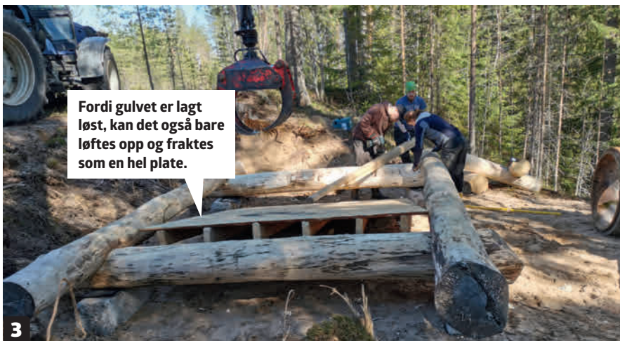
3 Vi legger fire solide fundamentsteiner under tømmerkassen, en under hvert hjørne. Deretter løftes én og én stokk på plass, med hjelp fra kranen til tømmertransporten.
