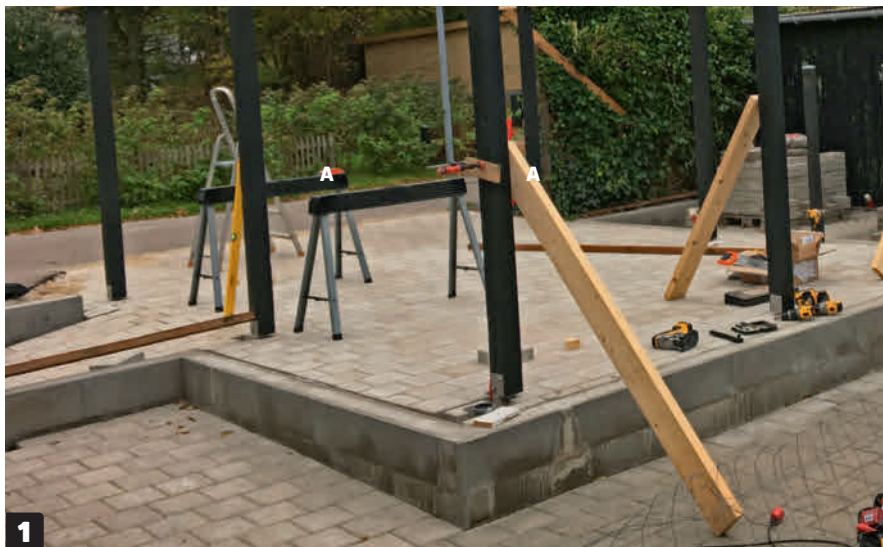
1 Asenna tolpat (A) tolppakenkiin ja tue tolpat suoriksi parilla lankulla.
