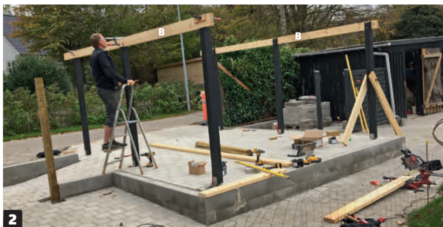
2 Takatolpan (A) pitää olla etutolppaa lyhyempi, jotta katto kallistuu taaksepäin.
