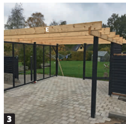
3 Asenna aluksi etupalkki, keskimääräinen palkki ja takapalkki (E), jotta rakenne jäykistyy. Sen jälkeen voit asentaa loput palkit niiden väliin. Pidä huoli, että palkit ovat vähintään 60 sentin välein.
