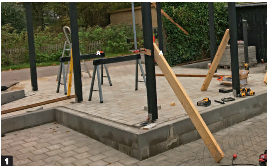
1 Sätt stolparna (A) i stolpskorna och stötta dem med ett par regler så att de står i lod.
