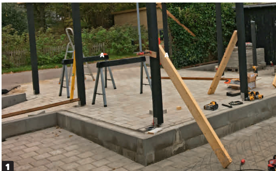
1 Monter stolpene (A) i stolpeskoene, og støtt dem opp med et par lekter når de står i lodd.
