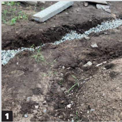
1 Tasanteet salaojitetaan kaivamalla kourut, jotka täytetään murskeella. Lopuksi maan pinnalle levitetään kuitukangas ja singelit.
