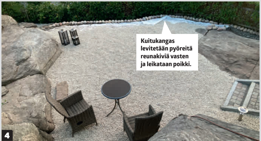
4 Lopuksi kaikki tasanteet peitetään singeleillä. Kivet toimitetaan suursäikeissä ja nostetaan pihalle kuorma-auton nosturilla, mutta ne pitää joka tapauksessa kärrätä eri tasoille kottikärryillä. Kivien alle levitetään kuitukangas, joka estää rikkaruohojen kasvua.
