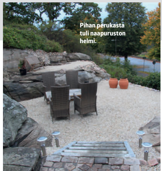
4 Lopuksi kaikki tasanteet peitetään singeleillä. Kivet toimitetaan suursäikeissä ja nostetaan pihalle kuorma-auton nosturilla, mutta ne pitää joka tapauksessa kärrätä eri tasoille kottikärryillä. Kivien alle levitetään kuitukangas, joka estää rikkaruohojen kasvua.
