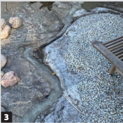
3 Kallion halkeamat valetaan umpeen niistä kohdista, jotka voivat täytyä vedellä ja kerätä roskaa. Se estää myös singeleitä huuhtoutumasta veden mukana.
