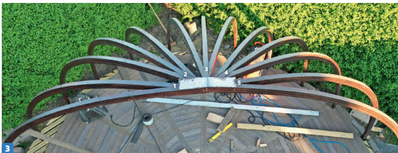
3 Yhdistä kaksi tai kolme palkkia toisiinsa, nosta ne pystyyn ja yhdistä ne keskeltä. Kiinnitä kaarien päät toisiinsa naulauslevyjen avulla.
