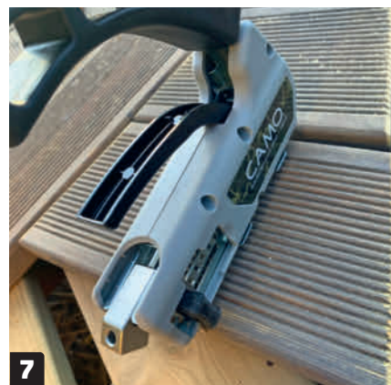
7 Kiinnitä laudat piiloruuveilla. Niistä on hyötyä etenkin tällaisessa tilanteessa, jossa ruuviriveistä on vaikea saada suoran näköisiä.
