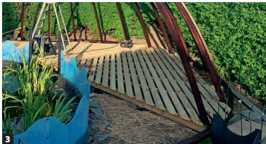
3 Asenna aluslaudat 2 sentin välein. Ne muodostavat tukevan ja tuulettuvan pohjan varsinaisille terassilautoille.
