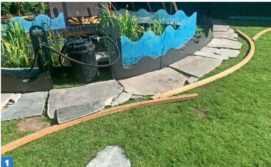
1 Kaikki kaarevat palkit sahataan oikean pituiseksi vasta, kun liima on kuivunut.
