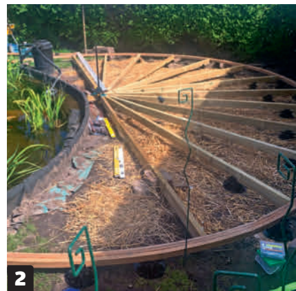
2 Asettele palkit siten , että niiden väliin jää enintään 60 senttiä tilaa. Sahaa palkkien sisäpää vinoiksi ja tue keskikohta isoilla laatoilla. Tue myös alapalkki pihalaatoilla.
