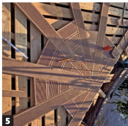
5 Täytä sektorit pienillä, viistoiksi sahatuilla laudanpätkillä. Jätä lautojen väliin vähintään 8 millin raot ja mittaa, että lautojen ulko-reunat ovat yhtä kaukana keskeltä.
