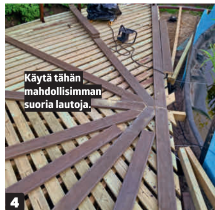
4 Jaa kansi kuuteen sektoriin seitsemällä laudalla, jotka ovat samassa linjassa runko-lankkujen kanssa. Sahaa lautojen päät vinoiksi, jotta ne sopivat yhteen keskellä.
