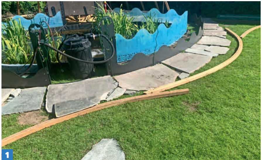
Alla de böjda takstolarna görs lite för långa och kapas först när limmet har torkat.
